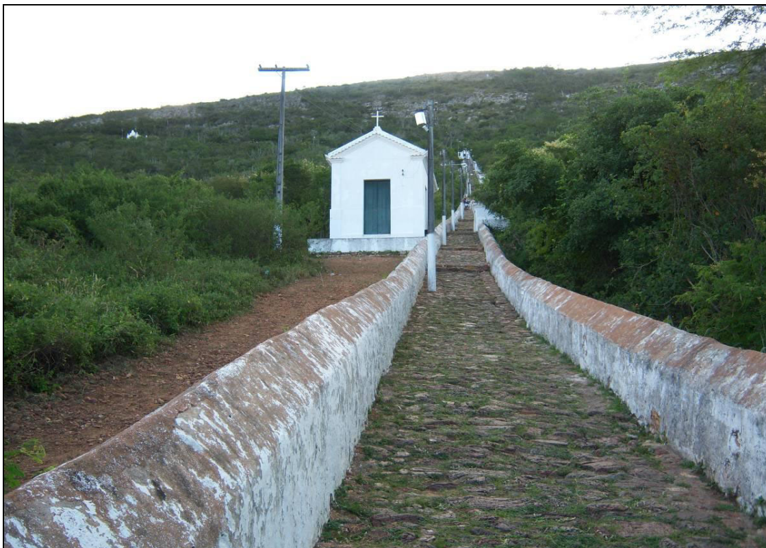
Imagem 116: Muro de arrimo da subida do Santuário da Santa Cruz.
