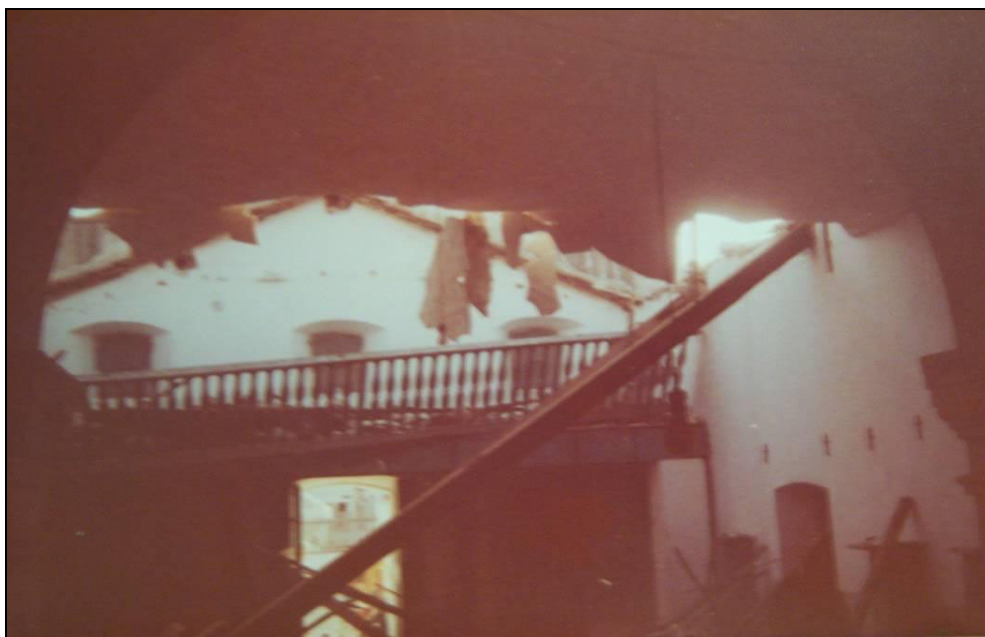
Imagem 93: Interior Igreja do Senhor do Bonfim de Chorrochó apresentando desabamento do telhado. Fonte: Acervo Neuza Menezes, década de 80 do século XX.
