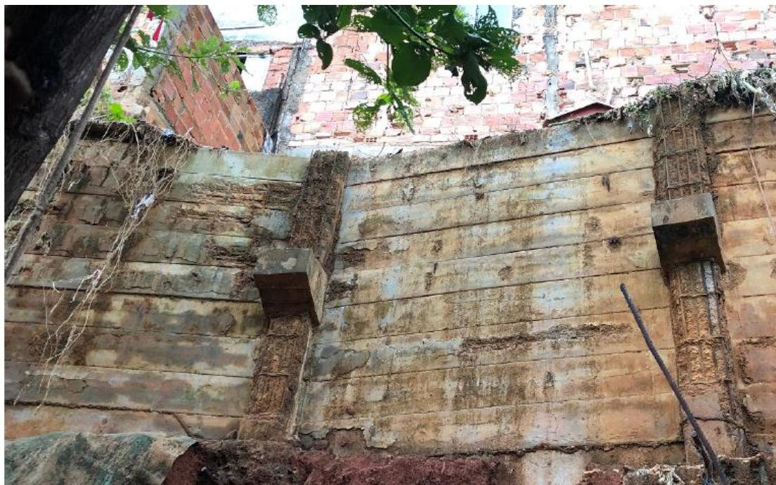
Figura 10 - Trecho da Contenção da Encosta da Rua Nova República a partir do quintal de um dos vizinhos. Fonte: Dossiê Encosta, Coletivo Escalar, 2020.
