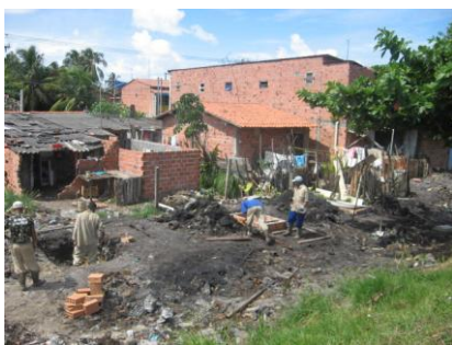
Figura 23 – Obras no fundo de uma das ruas na comunidade de Arembepe
