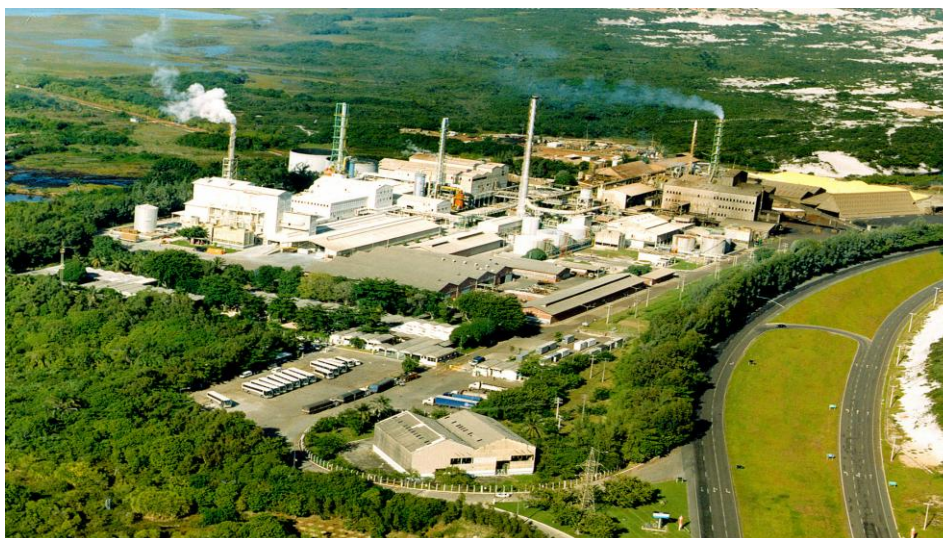
Figura 16 – Foto atual da fábrica
