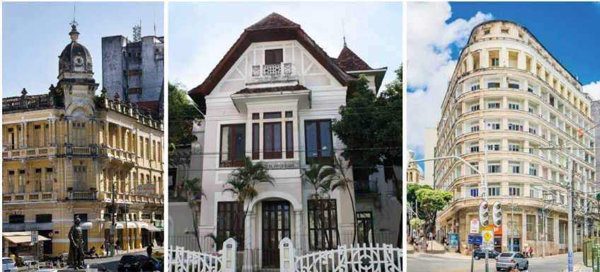
Figura 1 – Edifícios na Rua Chile, Rua Araújo Pinho e Carlos Gomes. Salvador, Bahia
