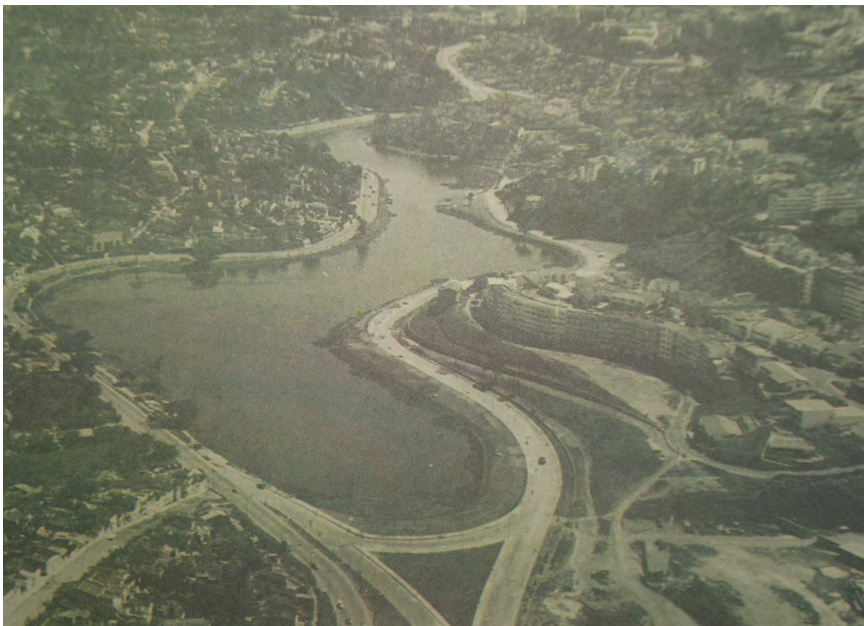
Fig.51. Dique com a construção da Avenida Costa e Silva anos 70.
