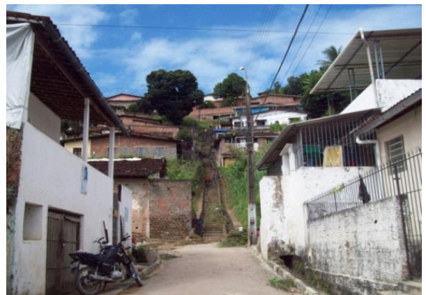
Figura 24 – Rua do Maracatu Nação Leão Coroado e, logo acima, casas em situação de risco de desabamento (Arquivo Margarete Conrado, 2010)
