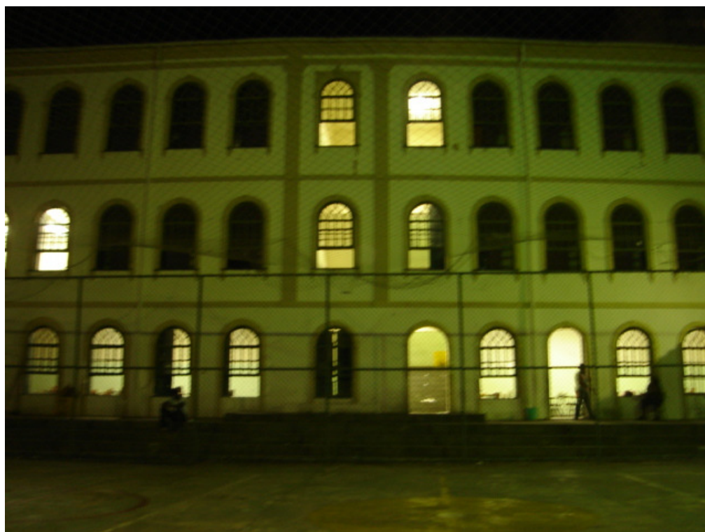
Foto 4: Interior da escola, vista do prédio de aulas.
