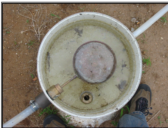
Figura 24: Tanque intermediário do conjunto evaporímetro
