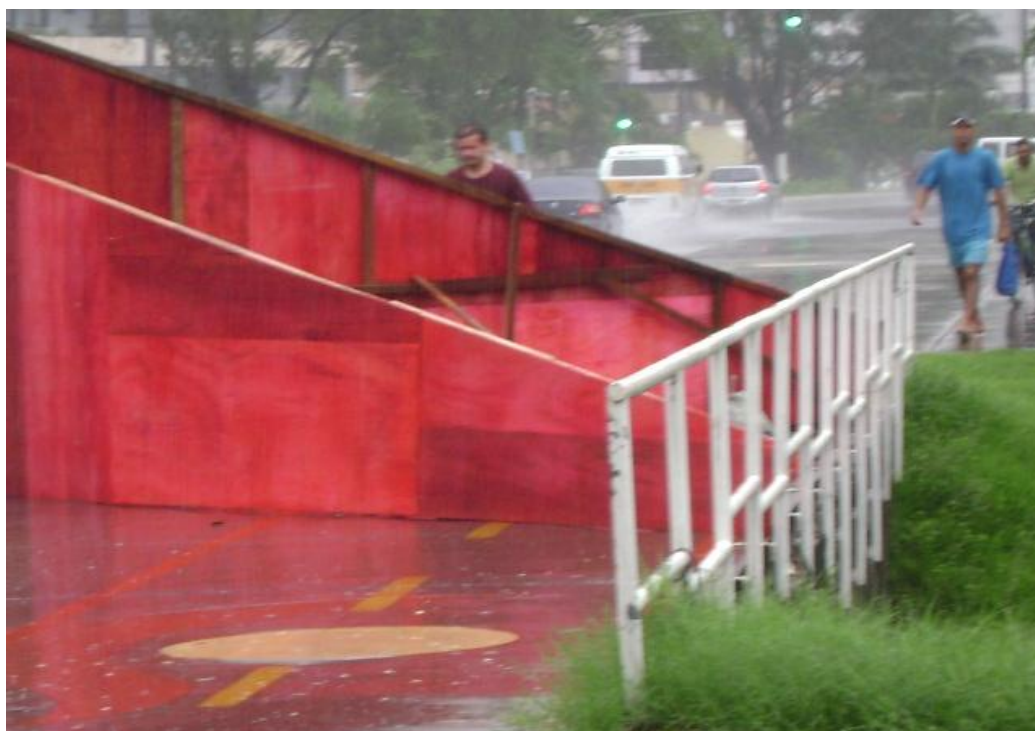
Fig. 51 – Calçadão da Praia 13 de Julho, Aracaju, SE -
