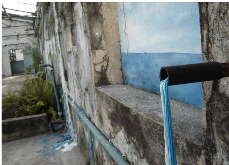
Obra 2 As indústrias. Vista lateral.
