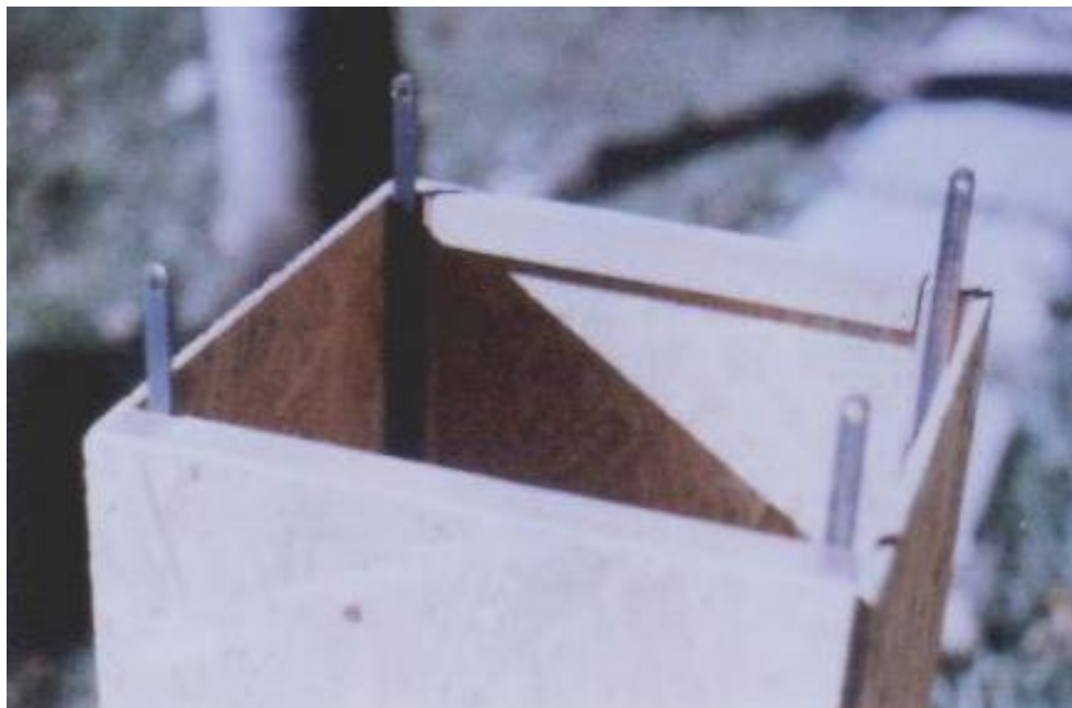
(fig.44) Detalhe do sistema de sustentação da obra foto: Alfaya
