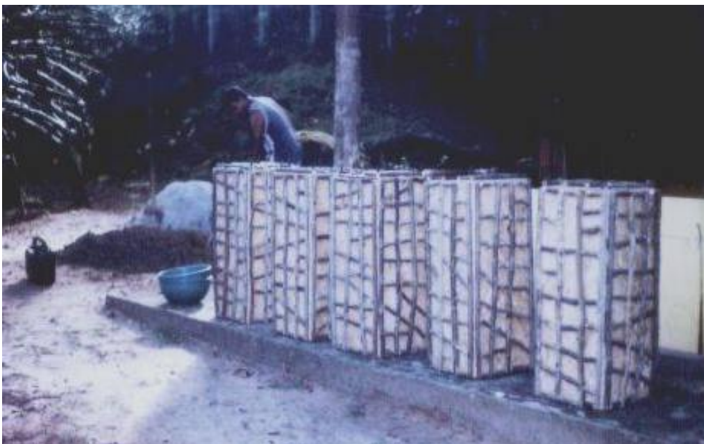
(fig. 36 e 37) Detalhes da construção da obra, C.G.S. II
