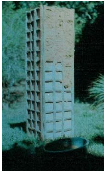
(fig.23) “Aplicação do barro sobre os caibros”
