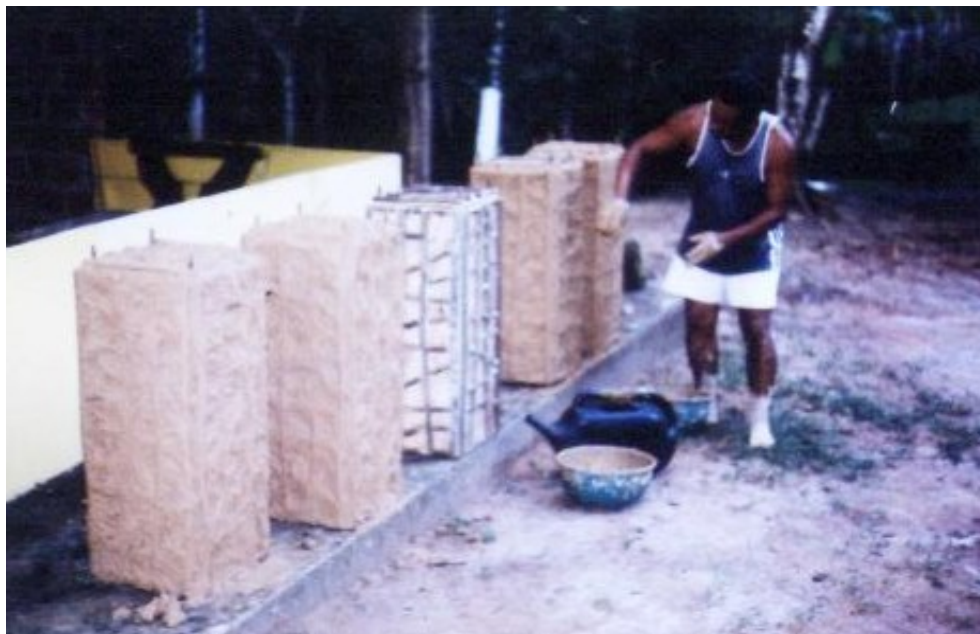
(fig. 38 e 39) Detalhes da construção da obra, C.G.S. II
