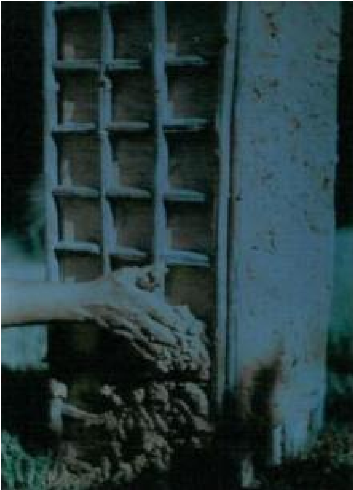
(fig. 28) detalhe da construção da obra, C.G.S. I.
