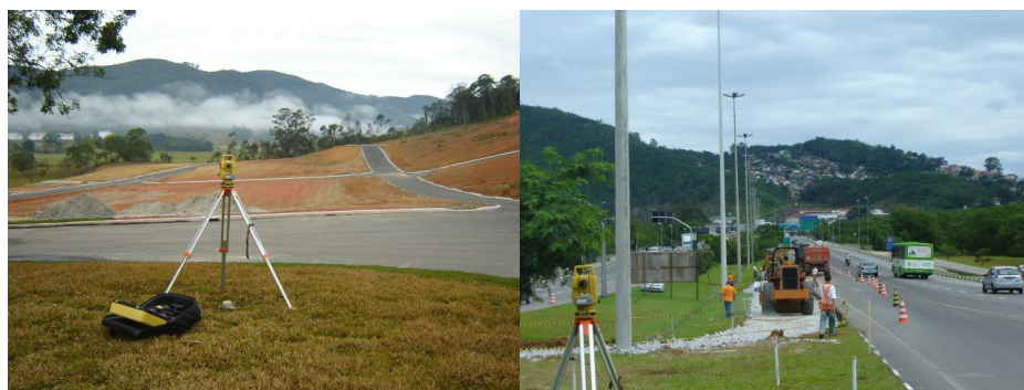
Figura 1 e 2. Levantamento topográfico de terreno (Construção de Estradas). Sett, 2010
