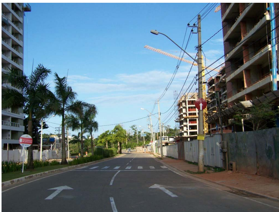
Figura 11 – Vista de novos prédios em construção no loteamento Alphaville, em área anteriormente coberta por floresta ombrófila densa.
