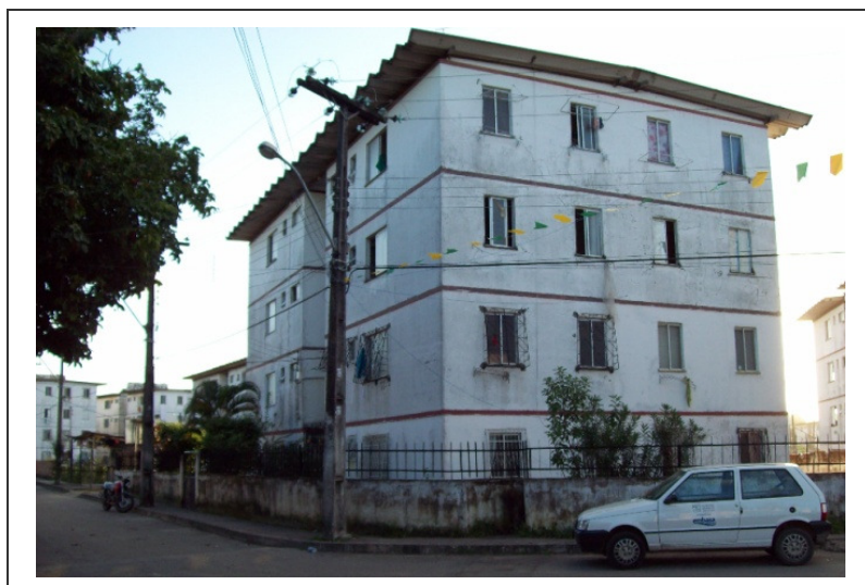
Figura 3.2 – Primeiro prédio com 16 apartamentos a implantar o sistema de medição individualizada na cidade do Salvador, em junho de 2006
