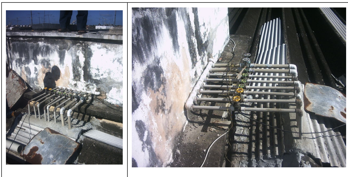
Figura 3.1 – Separação da ligação no reservatório superior, onde somente o síndico tinha acesso
