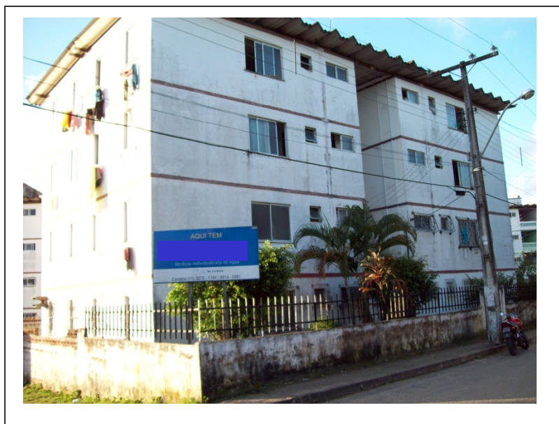
Figura 4.1 – Prédio popular com medição individualizada de água na cidade do Salvador
