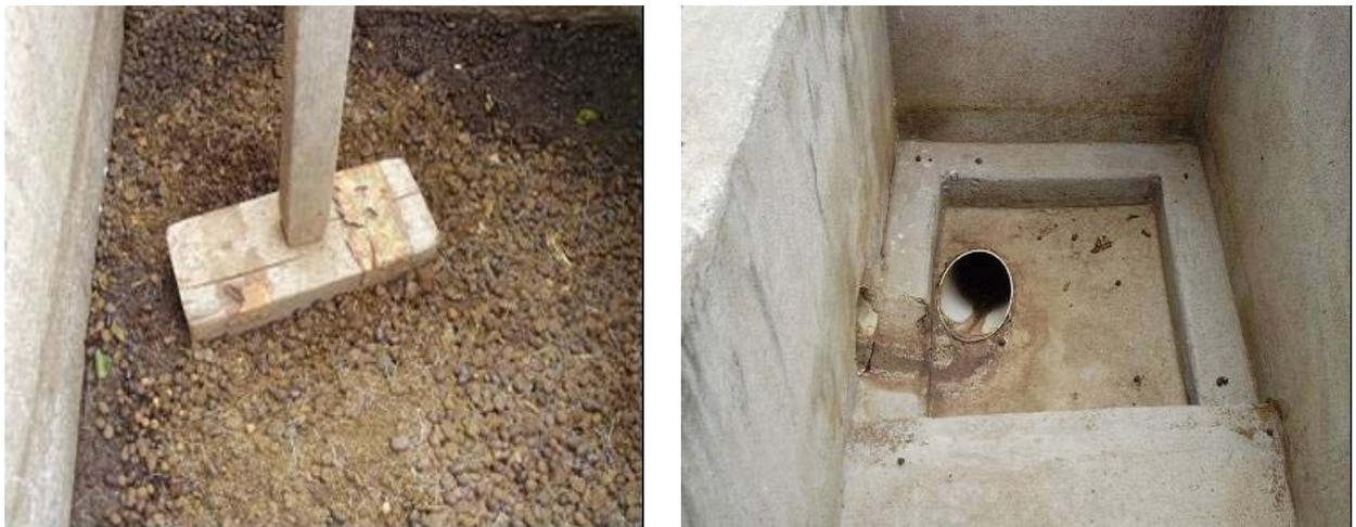
Figuras 17 e 18 - Pilão para amassar o estrume. A caixa recebe o estrume amassado dissolvido em água.
