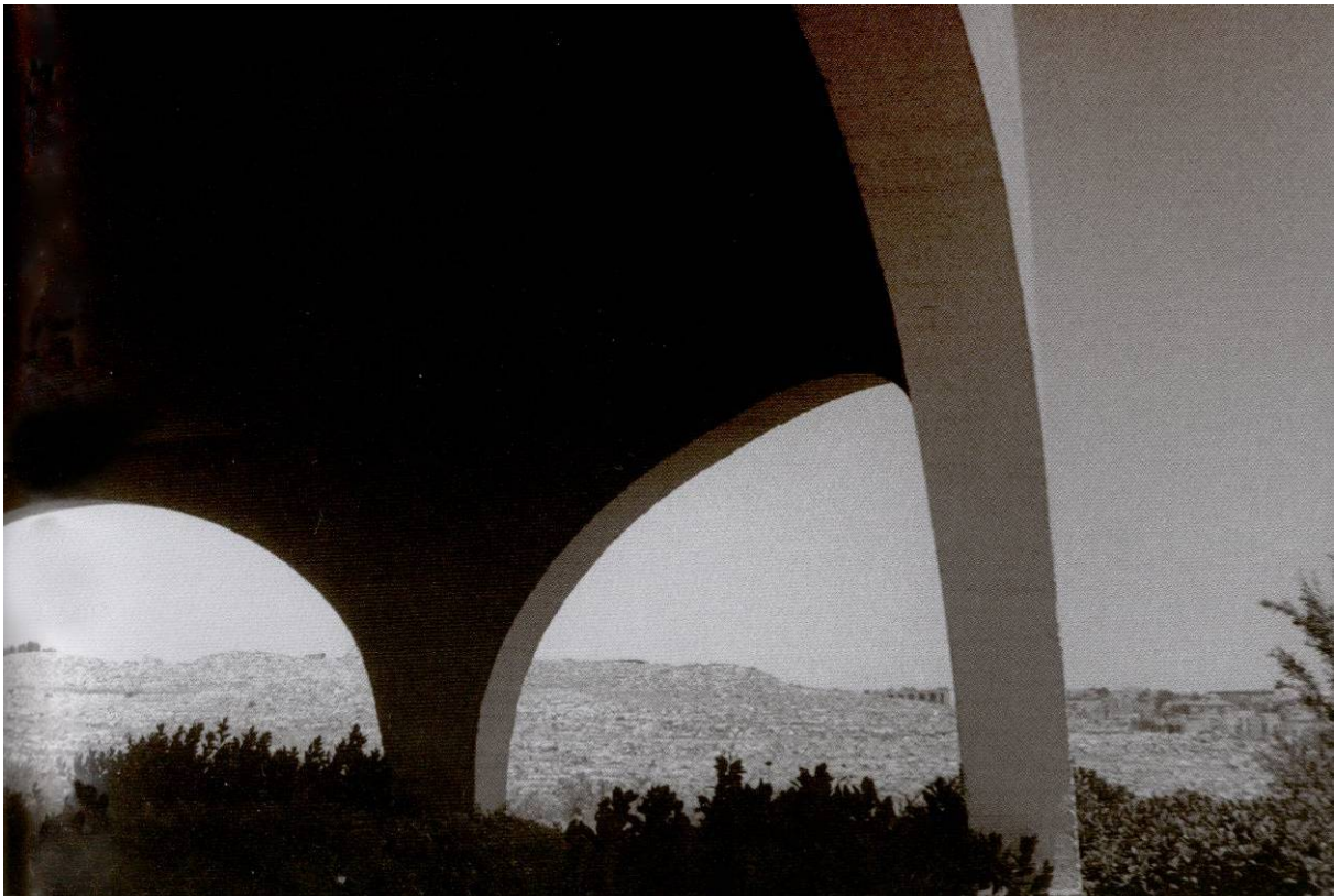
Sinagoga de Givat Ram, Jerusalém. Os arcos emolduram a paisagem histórica, tirando partido da cidade na contextualização do edifício. Fonte: DEKEL-CASPI, 2005, p. 45
