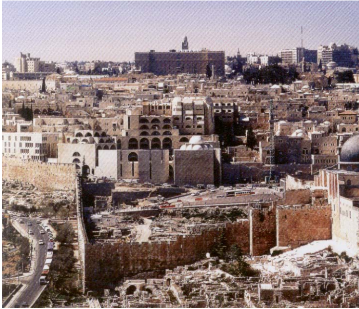
Sinagoga da Yeshivá Porath Yosef, Jerusalém, Israel, 1972 – Moshe Safdie. A sinagoga aparece no centro da imagem com domos brancos, ao lado do edifício da escola, caracterizado por grandes arcadas. Fonte: LEVIN, 2004, p.38.
