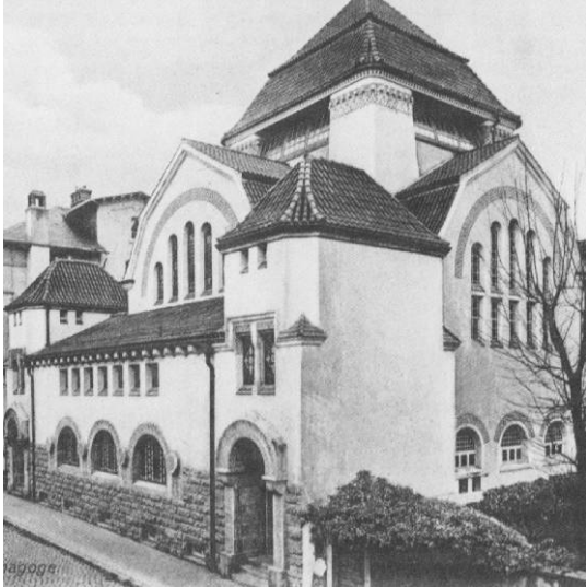
Sinagoga de Darmstadt (séc. XIX), destruída durante a Segunda Guerra.
