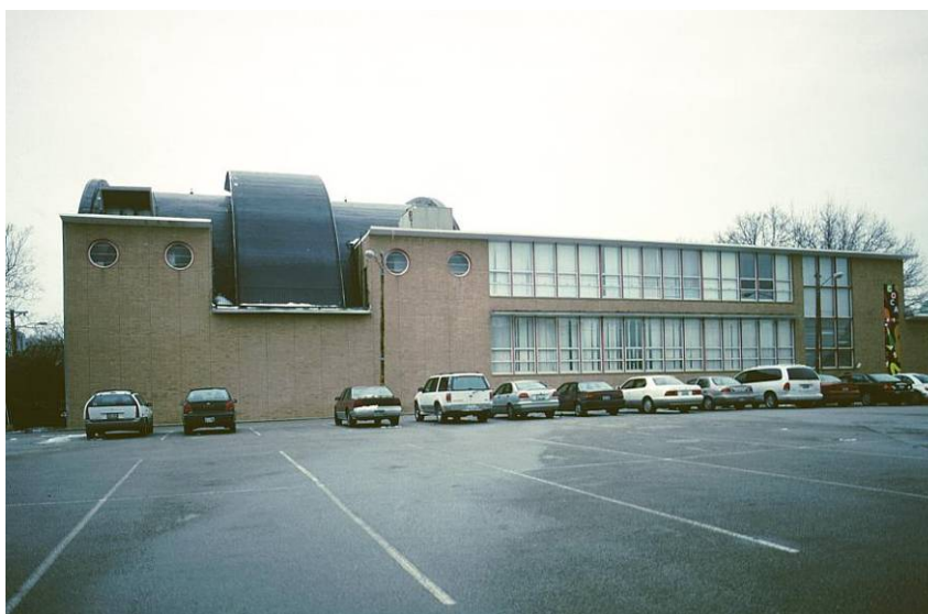
Sinagoga B'nai Amoona, 1950 – Erich Mendelsohn. Vista da fachada posterior, mostrando a cobertura e a faixa suspensa para a entrada de luz zenital. Fonte: www.bluffton.edu
