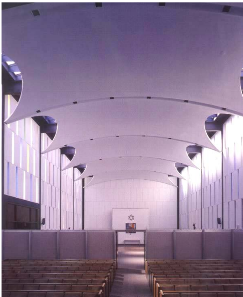
Congregação Kneses Tifereth Israel. Vista do interior em direção ao fundo do santuário. O forro de gesso remete ao uso do tecido como cobertura. Fonte: GRUBER, 2003, p. 111.
