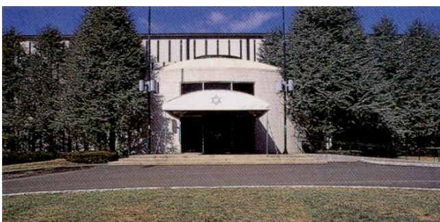
Congregação Kneses Tifereth Israel, Port Chester, NY, EUA, 1956 – Phillip Johnson. Vista do exterior. Fonte: GRUBER, 2003, p. 110.
