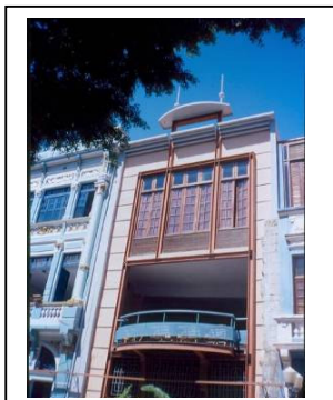
FIGURA 7.15: A estrutura metálica lembra a tradicional estrutura em madeira, realizando uma ponte entre o antigo e o contemporâneo: Edifício comercial no Pólo Bom Jesus (Recife, PE, década de 90) (Foto: Flavio Carsalade)
