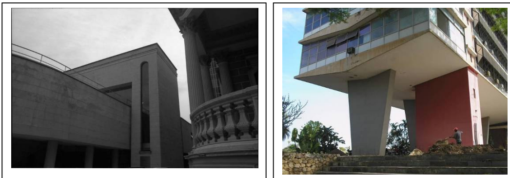
FIGURA 8.9: Acertos e desacertos: Diálogo das formas entre o edifício antigo e o novo na Academia Mineira de Letras (Belo Horizonte, MG, projeto: Arquiteto Gustavo Penna) e a nova escada de incêndio e o engrossamento da linha plana das lajes para melhorar a drenagem rompem com toda a intenção de leveza conseguida no projeto original de Eduardo Mendes Guimarães para o edifício da Reitoria da UFMG (Belo Horizonte, MG)
