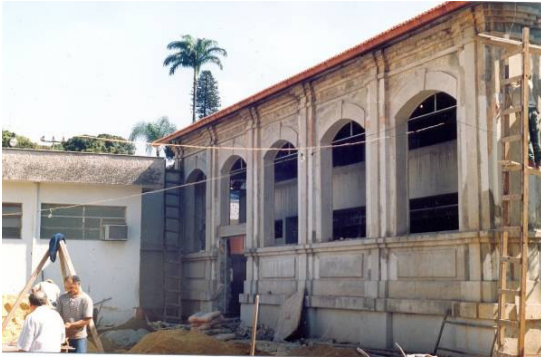
FIGURA 6.13: Restauro do edifício sede do SERVAS em Belo Horizonte: Trata-se de um trabalho de recomposição da matéria que aí ainda se encontrava de forma latente, recuperando sua expressividade externa. Do ponto de vista interno, face à impossibilidade de seu aproveitamento para novo uso, optou-se pela inserção de algo totalmente novo, fisicamente descolado do original, até para reforçar a sua diferença. (Foto: IEPHA/ MG)
