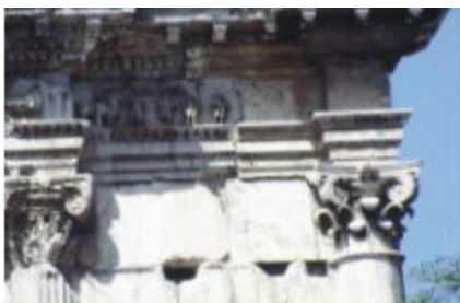
FIGURA 6.1: Arco de Tito (Restauro de Stern e Valadier, 1817-1824): nas partes reconstituídas foram usados um mármore diferente e formas simplificadas, de maneira a distinguir claramente o original da intervenção. (Fonte: MARCONI, 2004)
