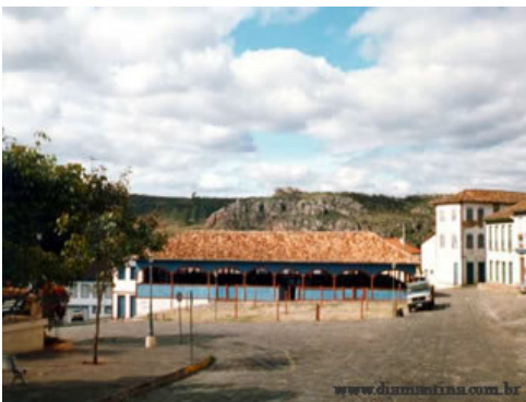
FIGURA 6.14: Restauro da Praça Barão de Guaicuí em Diamantina: O IPHAN sugere a construção de uma quase réplica de coreto anteriormente existente na cidade, com grande dificuldade em aceitar um design mais contemporâneo, embora este esteja localizado em área de renovação visual do contexto. Parece haver um cuidado excessivo com a “historicidade” do lugar, que lhe tire o “ar antigo de foto”. (Foto: Prefeitura de Diamantina)
