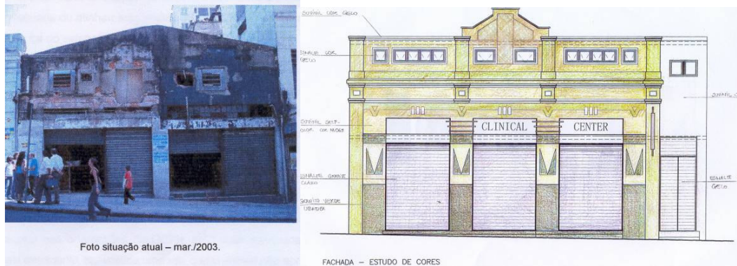
FIGURA 6.16: Restauro à Rua dos Caetés, 188 em Belo Horizonte: Paradoxo: pode-se “voltar” algo ao que nunca foi? Não se sabe se o edifício foi construído conforme o microfilme. (Fotos e desenhos de Flavia Assis Lage)
