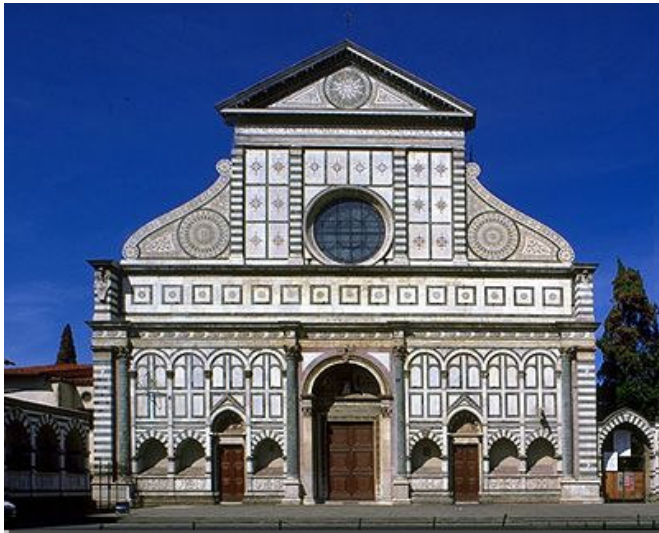
FIGURA 6.3: Igreja de Santa Maria Novella, Florença, Itália: Restauro de Leon Batista Alberti (1450), onde o arquiteto recria a pré-existência em uma nova forma coerente com a sua visão de época. (Fonte: www.centrica.it )
