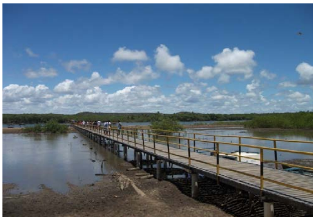
Foto 1: Ponte de acesso ao rio Itapicuru
