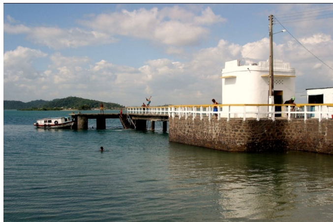
Foto 8: Ponte de chegada dos barcos de passageiros
