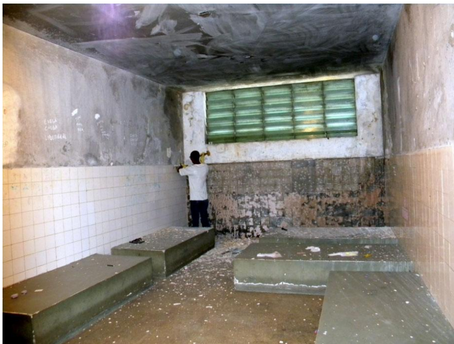
Foto 8 – Quarto do alojamento feminino em reforma
