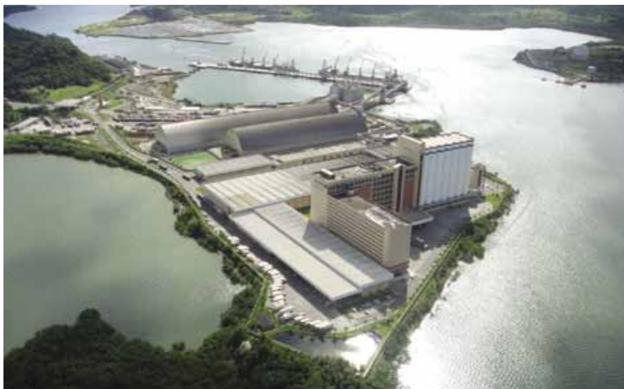
Figura 5 – Canal de Cotegipe, onde se pode visualizar o complexo industrial e o porto do Moinho Dias Branco, tendo à frente o Terminal da Dow Química (direita) e o Terminal Portuário Miguel de Oliveira (esquerda). Fonte: Berger e Berger (2009).
