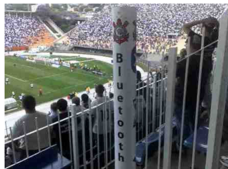
Figura 126: Antenas espalhadas no estádio.
