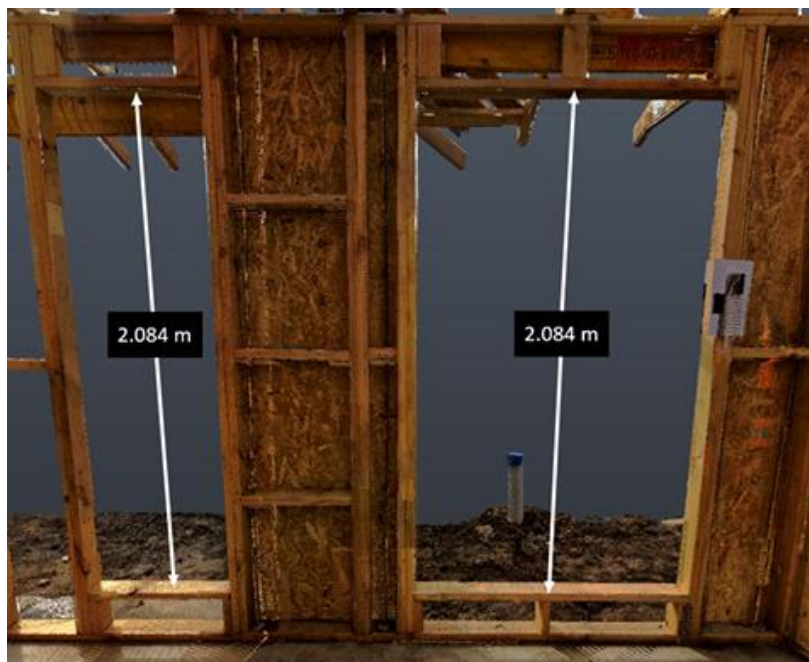
Figura 8. Medição das Janelas na Nuvem de Pontos.
