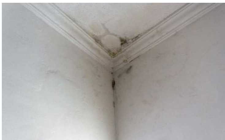
Figura 13. Mancha de Infiltração.
