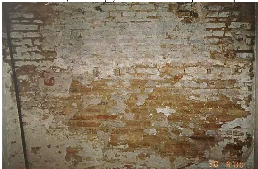
Figura 115- Vista da parede de um dos ambientes do pavimento térreo, observa-se a alvenaria em tijolo maciço, assentamento do tipo de comprido.
