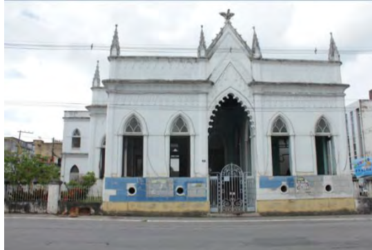
Figura 160 – Fachada noroeste do bloco principal.
