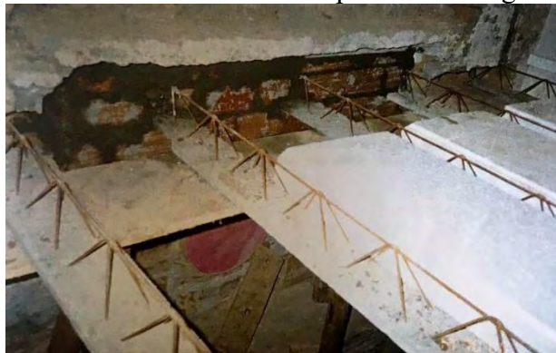
Figura 116- Vista das nervuras engastadas na alvenaria do edifício e colocação do enchimento em blocos de isopor entre as vigotas.
