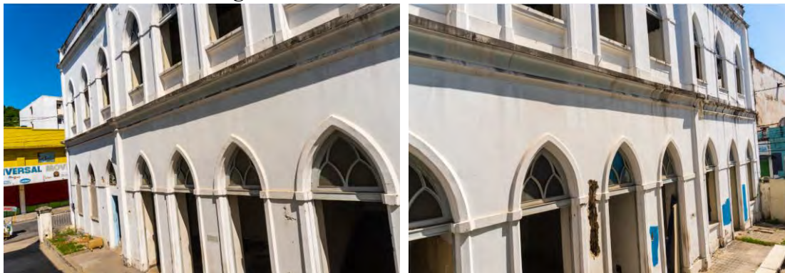
Figuras 313 - Fachada noroeste do anexo.
