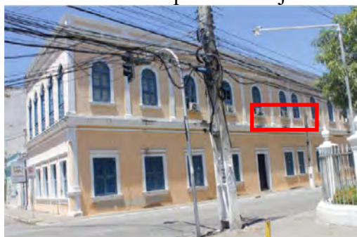
Figura 283 – Fachada do prédio da SETRAND, em destaque os condensadores do ar condicionado no peitoril das janelas.
