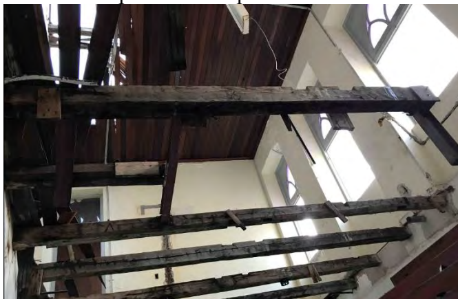
Figura 105 – Vista dos barrotes e de algumas tábuas em madeira do piso do pavimento superior do anexo.
