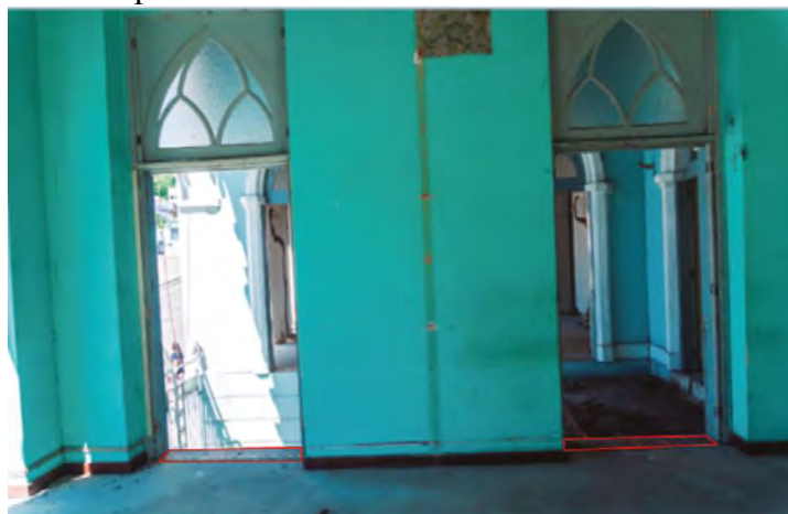
Figura 91 – Vista interna das janelas rasgadas do ambiente do pavimento térreo. Em destaque os ladrilhos hidráulicos localizados nas soleiras.
