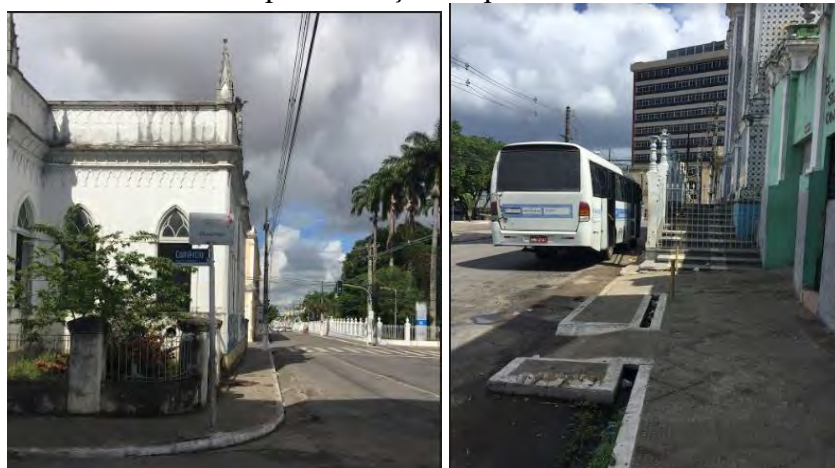
Figuras 251 e 252 – A calçada do edifício da Intendência Municipal com dimensão de 1,47cm de largura e a calçada próxima à Igreja dos Martírios, evidenciando a falta de padronização do passeio.
