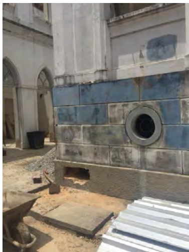
Figuras 133 e 134 – Vista de uma das caixa coletoras do bloco principal localizada na fachada nordeste.
