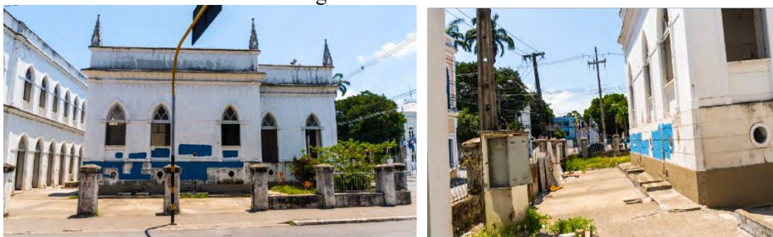
Figuras 97 e 98 – Fachadas nordeste e sudoeste do bloco principal do edifício da antiga Intendência de Maceió.
