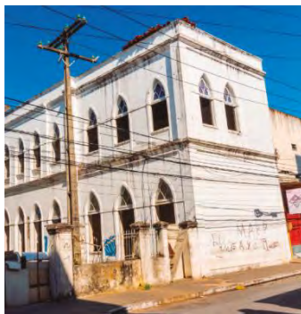
Figura 111 – Fachada sudoeste do anexo da Intendência de Maceió.
