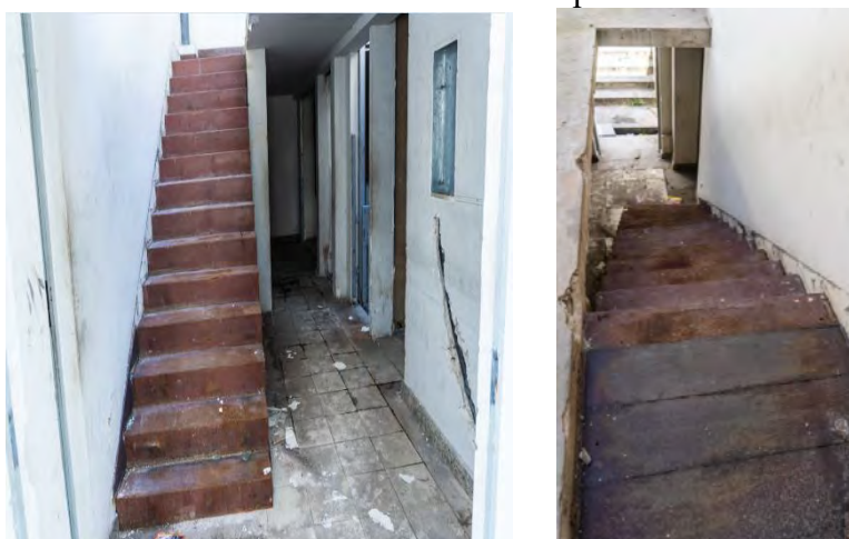
Figuras 173 e 174 – Vista da escada reta em estrutura metálica. A figura 174 mostra as tábuas em madeira revestindo o patamar da escada.
