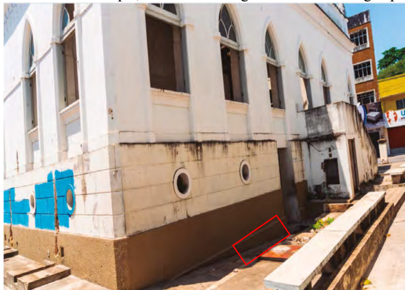
Figura 138 – Trecho da fachada sudeste do bloco principal do edifício da antiga Intendência. Em destaque, a canaleta com grelha coletora de água pluvial.
