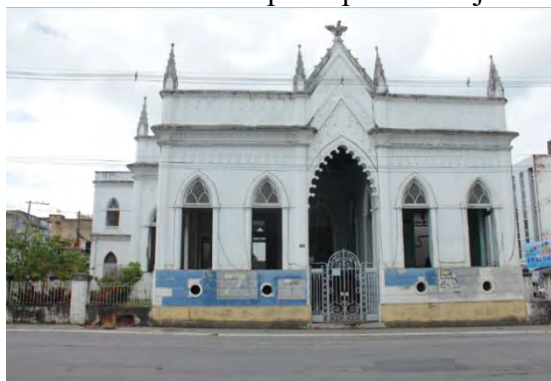
Figura 348 — Fachada noroeste do bloco principal do conjunto da antiga Intendência.
