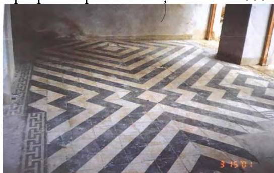
Figura 62- Piso em ladrilho hidráulico encontrado no pavimento térreo do bloco anexo que passou por restauração no ano 2000.
