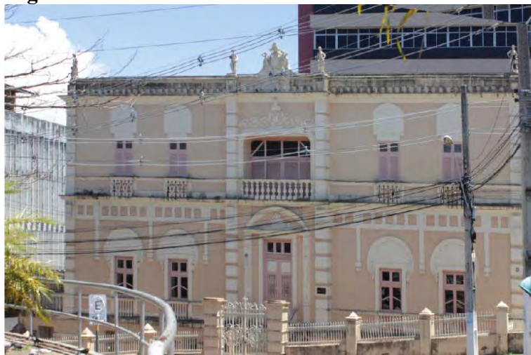
Figura 279 – Fachada do edifício do Museu Pierre Chalita.
