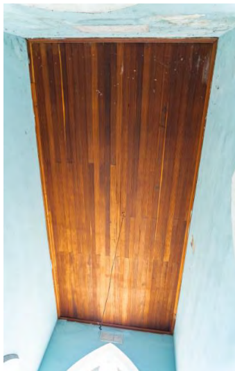
Figura 153 – Vista do forro tabuado do ambiente do vestíbulo.
