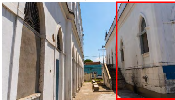
Figura 99 – Fachada sudeste do bloco principal edifício da antiga Intendência de Maceió, ver destaque.
