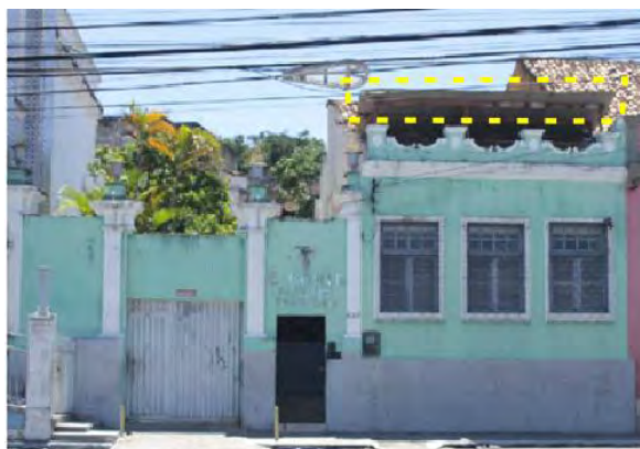
Figura 259 – Vista da fachada do imóvel contíguo a Igreja dos Martírios. Em destaque, na cor amarela a telha de fibrocimento.
