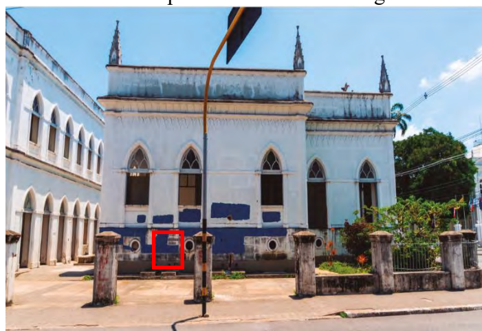
Figura 320- Fachada nordeste do bloco principal, em destaque o local onde foi retirado a amostra para análise microbiológica.
