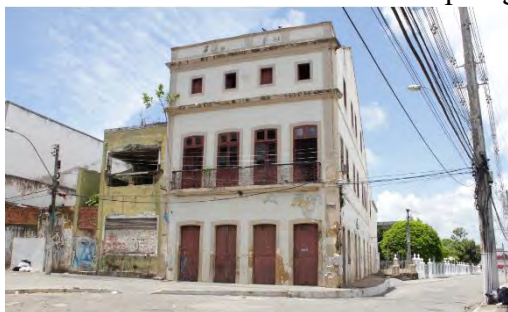
Figura 264 – Vista da fachada do edifício com tipologia de sobrado.
