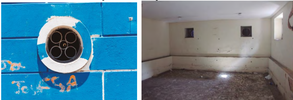
Figuras 162 e 163 – Vista externa e interna do óculo do ambiente 05 do pavimento porão alto, respectivamente.
