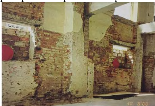
Figura 57 – No pavimento porão alto após remoção da laje, averiguou-se a altura 1,90m que representa o pé direito do porão alto original.
