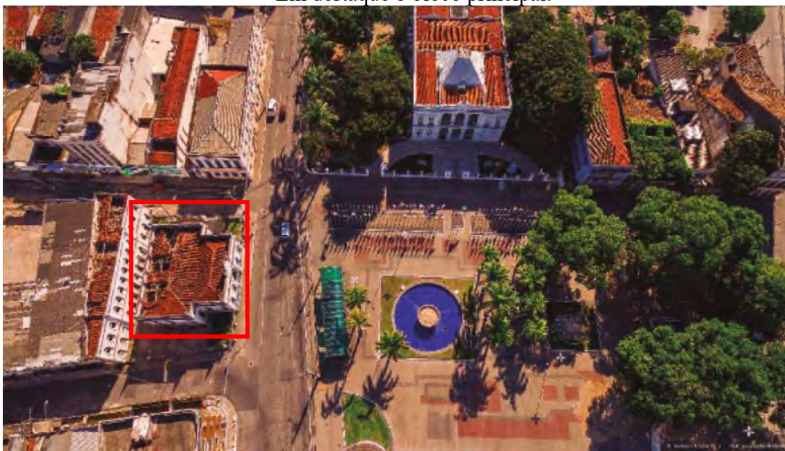
Figura 86- Imagem aérea do entorno imediato da Praça Marechal Floriano Peixoto. Em destaque o bloco principal.
