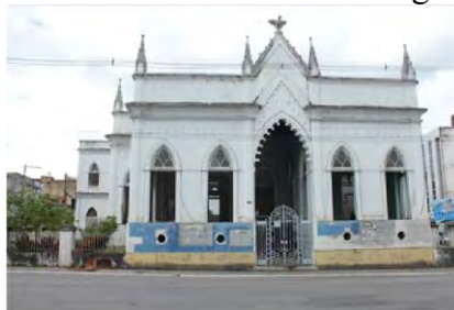
Figura 284 – Fachada do edifício da antiga Intendência.
