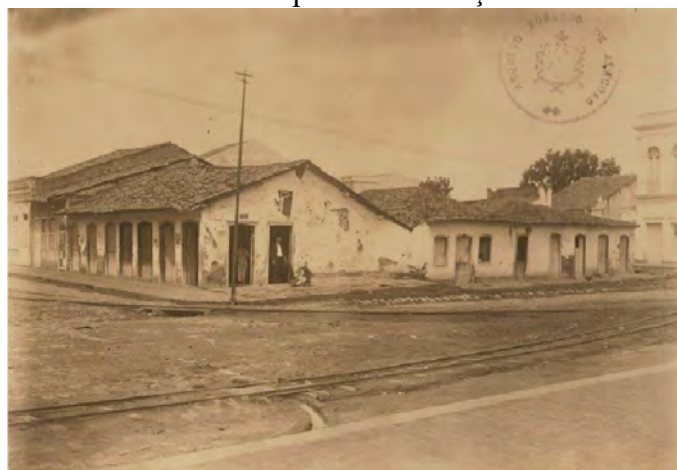
Figura 27- Casas térreas demolidas para a construção do edifício da Intendência.
