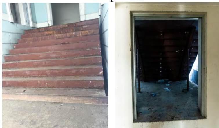
Figuras 170 e 171 – Vista frontal da escada em estrutura metálica que comunica o vestíbulo ao hall do edifício. A figura 171 mostra as colunas de ferro apoiadas na estrutura em ferro que sustentam a escada.
