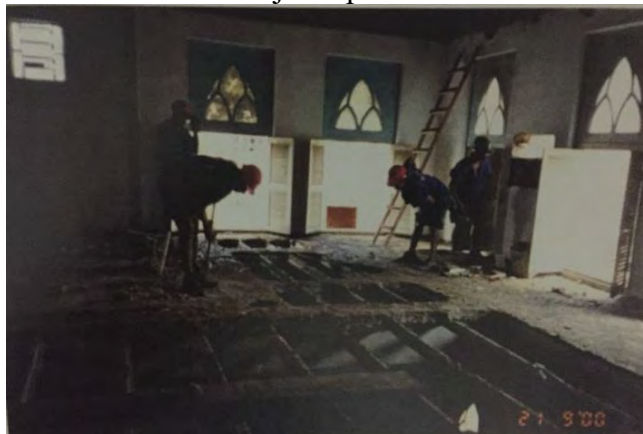
Figura 56 – Operários demolindo a laje do pavimento intermediário do bloco anexo.
