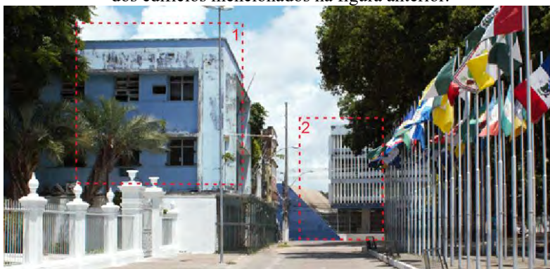
Figura 19 – Vista da Rua Boa Vista. Em destaque, as construções com feições modernas erguidas no local dos edifícios mencionados na figura anterior.
