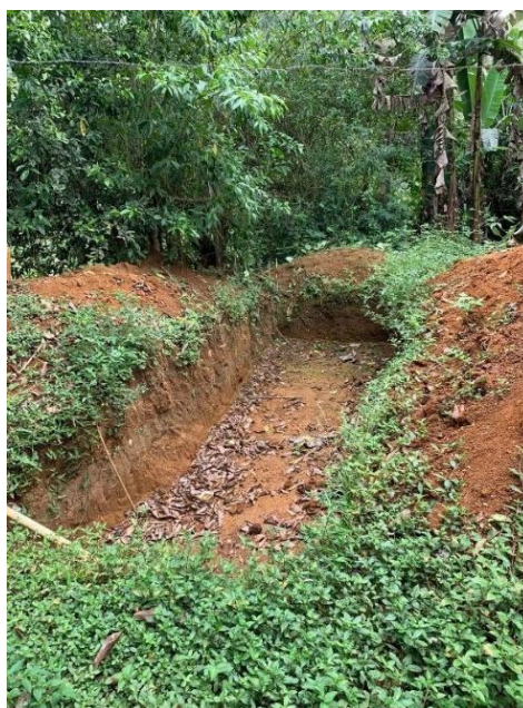
Figura 35 – Vista da escavação manual do solo do manualmente para implantação do Tevap. Assentamento Conjunto Laranjeira. Maraú/Itacaré, Bahia. 2022
