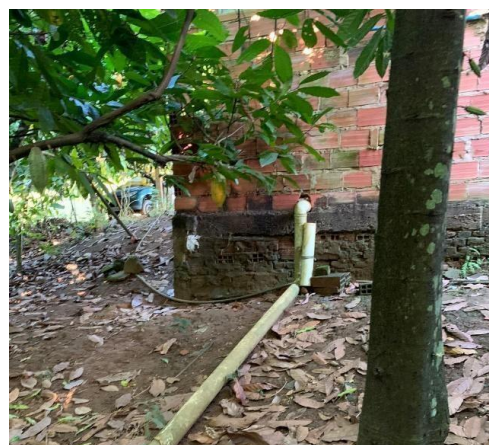
Figura 32 – Canalização da fossa absorvente no quintal da Residência 1. Assentamento Conjunto Laranjeira. Maraú/Itacaré, Bahia. 2022
