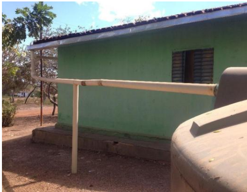
Figura 61 - Torneira e tubulação e da cisterna para a captação da água das chuvas 2.
