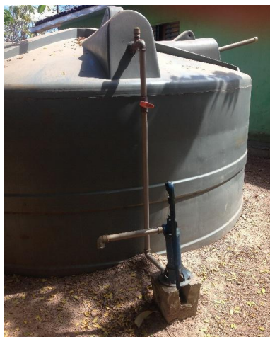
Figura 60 - Torneira e tubulação e da cisterna para a captação da água das chuvas 1.
