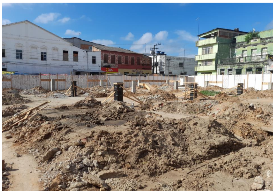
Imagem 79. Obra do Largo do Mercado - Início da construção dos pilaretes de concreto armado, base para os pilares metálicos que sustentam a cobertura. Arquivo do autor, março de 2023.
