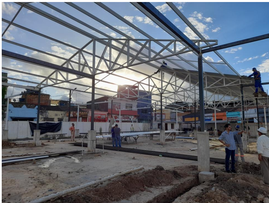
Imagem 80. Montagem da estrutura do telhado com cobertura com telhas metálicas, e instalação do sistema de drenagem. Arquivo do autor, abril de 2023.
