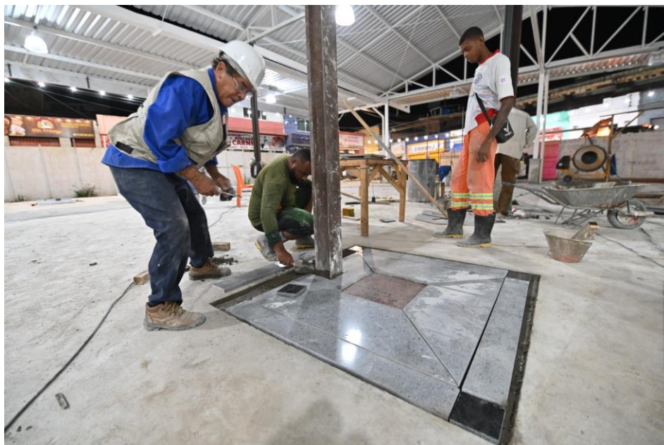
Imagem 82. Montagem do pilar de sustentação da cumeeira e detalhe do acabamento da moldura em granito, no centro do Barracão. Arquivo do autor, maio de 2023.
