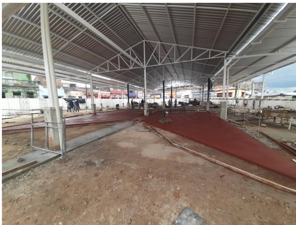
Imagem 81. Construção do piso, Oxé de Xangô . Arquivo do autor, maio de 2023.
