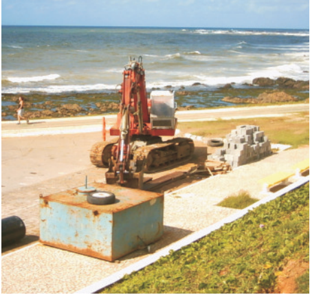
recomposição da calçada
