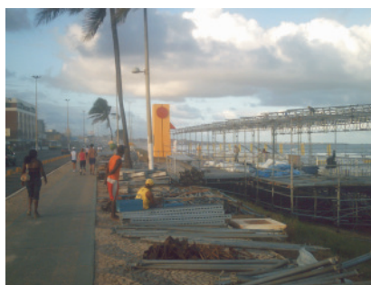
peças da estrutura na calçada
