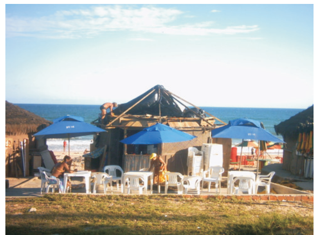
Foto 82 - reparo da cobertura, corsário
