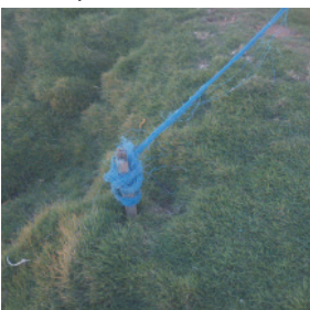
tirante preso no talude
