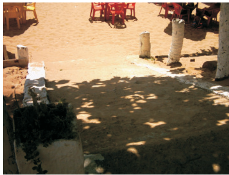
rampa de alvenaria
