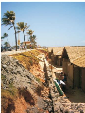
corte e erosão na parte superior do talude
