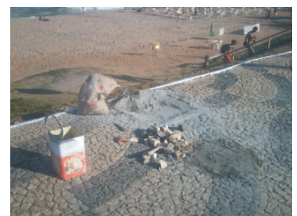
reforma da calçada
