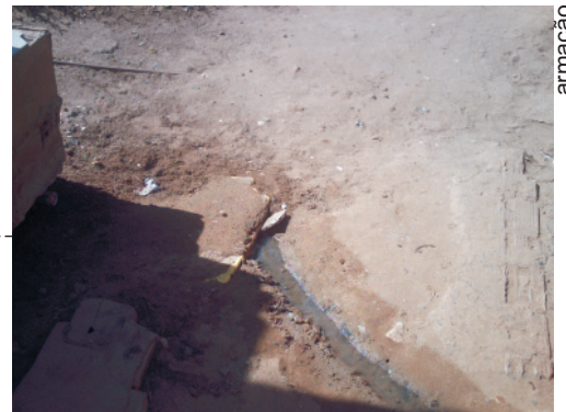
vazamento de esgoto
