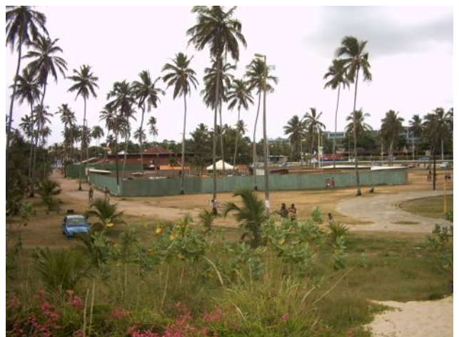
18 - canteiro de obras no parque dos coqueiros
