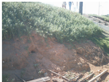
corte e erosão na parte inferior do talude
