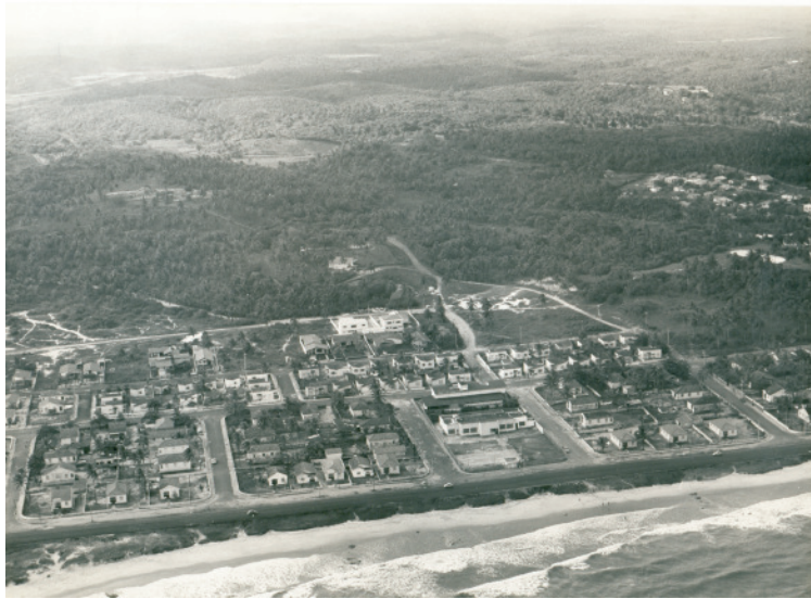
Foto 150 - vila dos funcionários da base aérea de salvador
