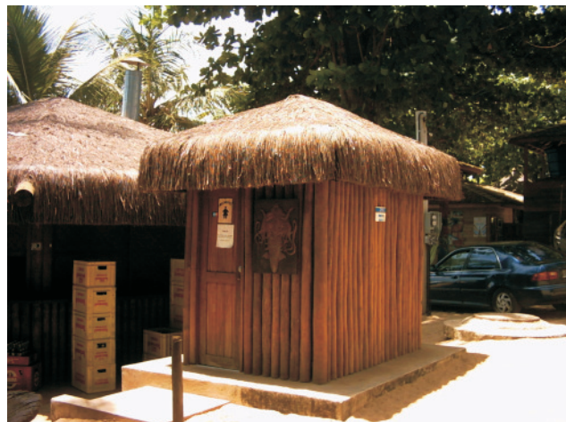
revestimento de troncos de madeira
