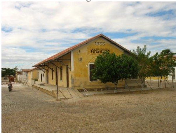
Figura 39: Estacao ferroviaria de Angicos
