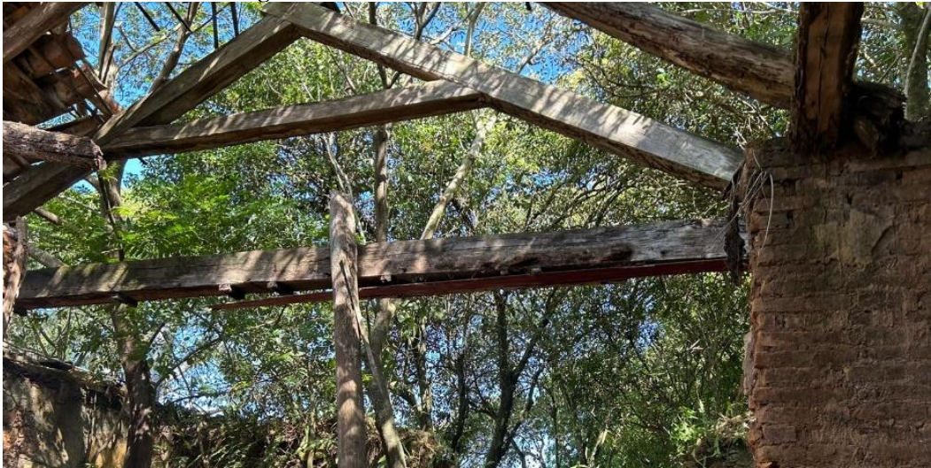
Figura 137 - Tesoura de madeira com linha alta
