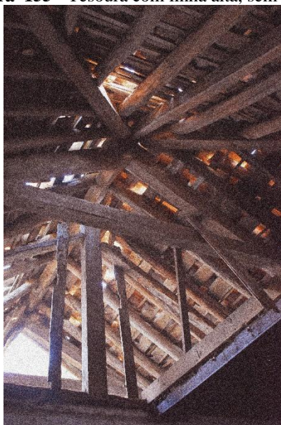
Figura 155 - Tesoura com linha alta, sem tirante
