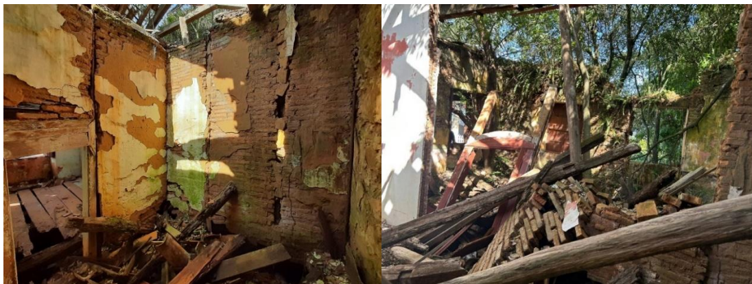
Figura 214 - Monitoramento do dano entre alcova e sala senhorial
