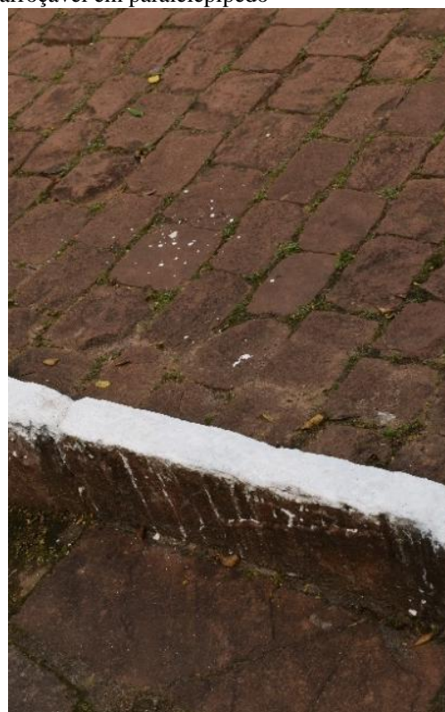
Figura 96 - Calçada, meio fio e leito carroçável em paralelepípedo
