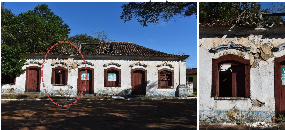
Figura 190 - Janela JA2. Possível observar o desprendimento do reboco e as raízes da árvore que brotaram no topo da parede
