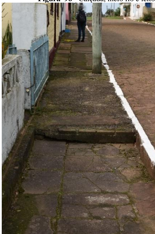
Figura 96 - Calçada, meio fio e leito carroçável em paralelepípedo
