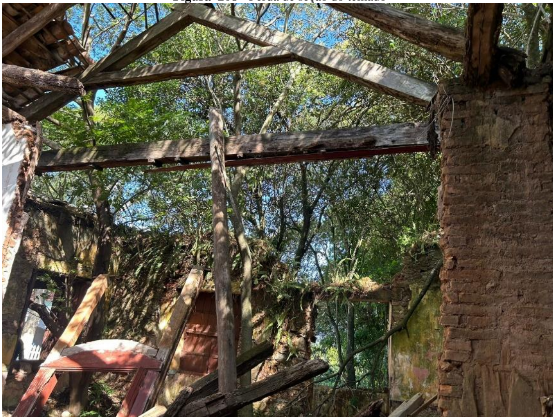
Figura 208 - Perda de seção do telhado
