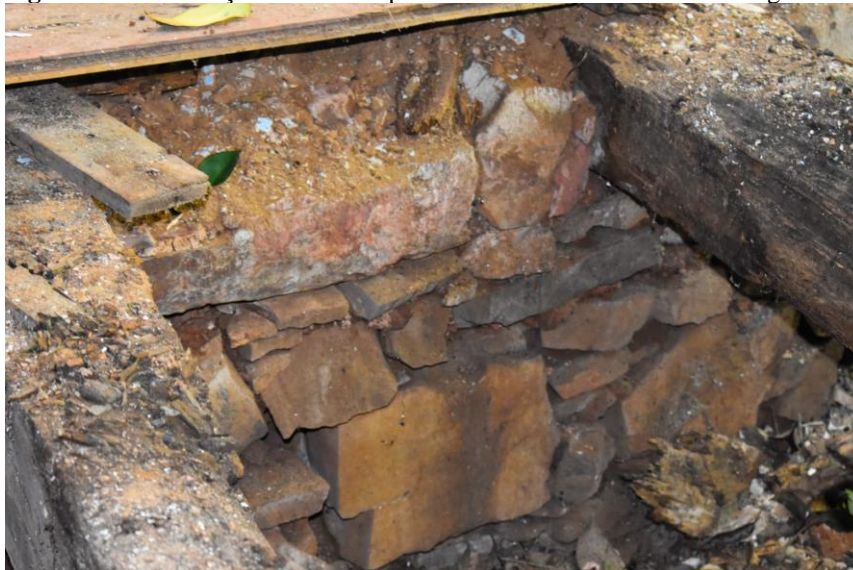
Figura 206 - Fundação corrida em pedra seca e barrotes de madeira degradados
