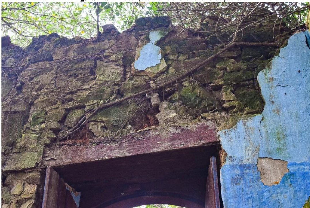
Figura 209 - Presença de raízes na alvenaria de pedra
