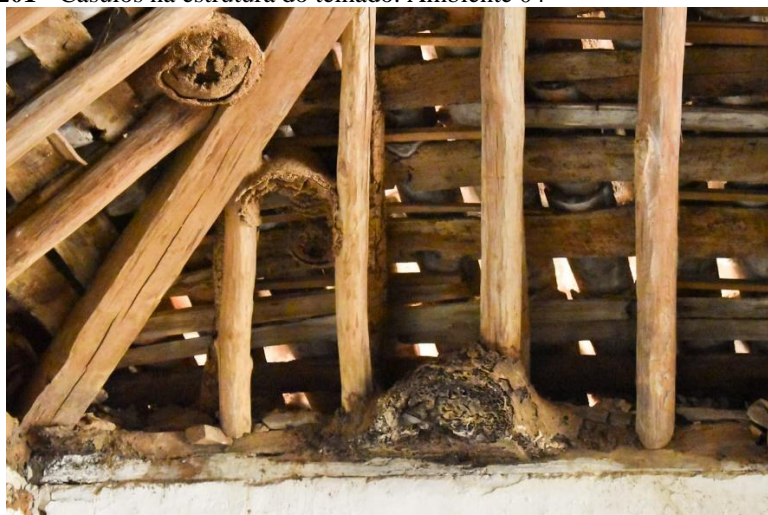
Figura 201 - Casulos na estrutura do telhado. Ambiente 04
