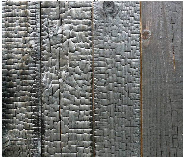
Figura 283 Exemplo Shou sugi ban - Madeira Carbonizada
