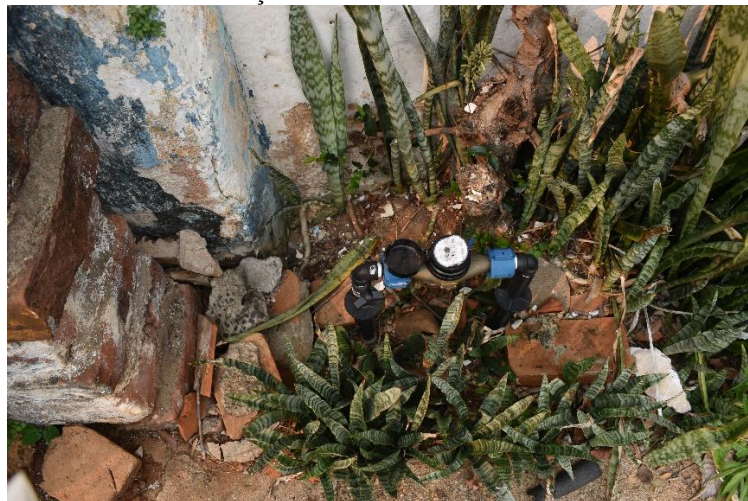
Figura 195 - Hidrômetro e tubulação de PVC na fachada norte
