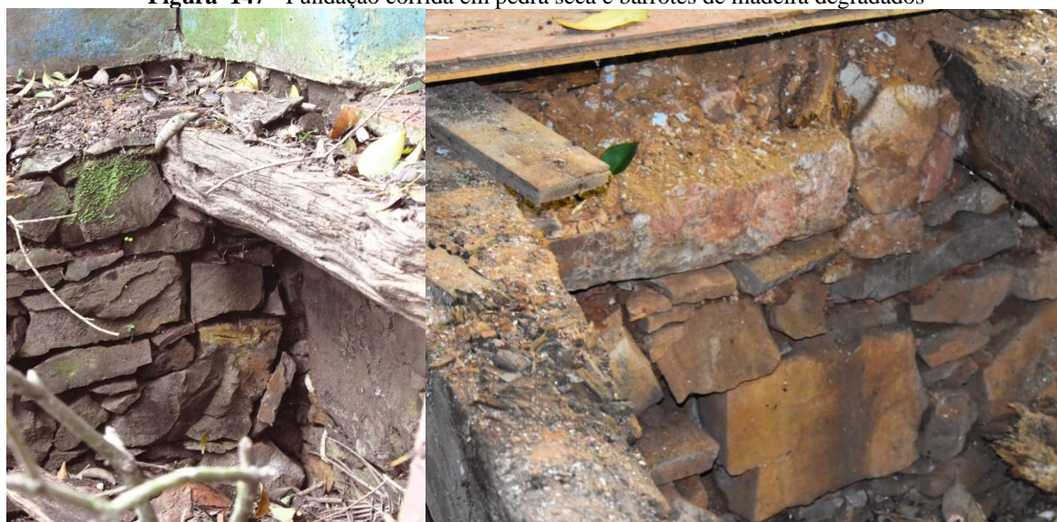
Figura 147 - Fundação corrida em pedra seca e barrotes de madeira degradados
