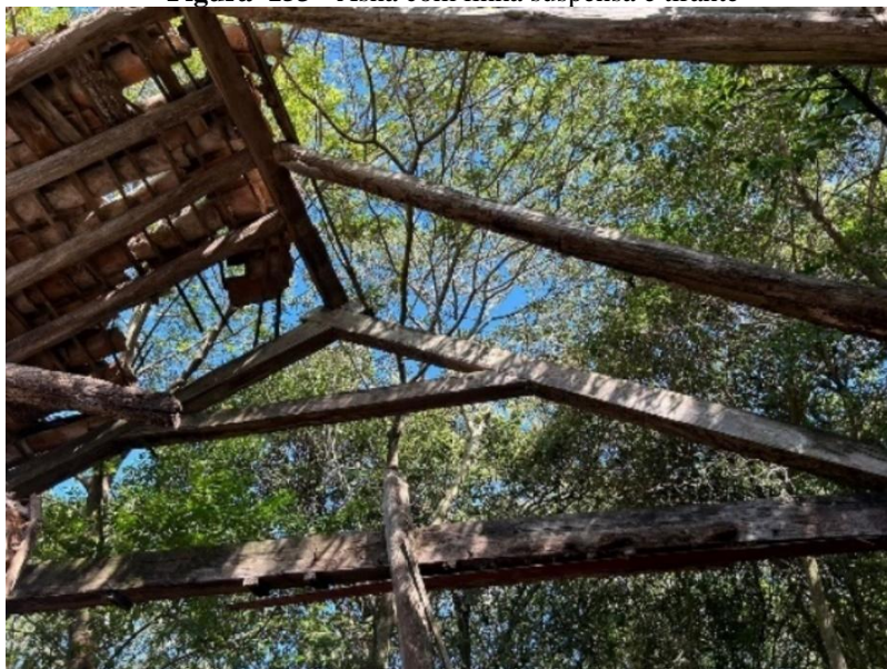
Figura 153 - Asna com linha suspensa e tirante
