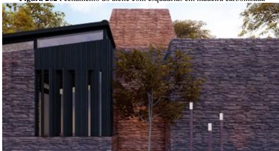
Figura 262 Fechamento do ateliê com esquadrias em madeira carbonizada
