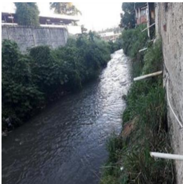
Figura 34- Direcionamento de esgoto doméstico na Avenida San Martin.
