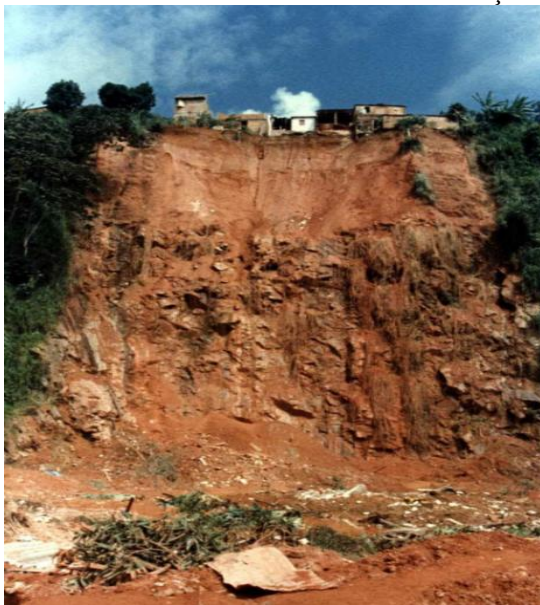
Figura 26 - Rompimento do talude de solo da Pedreira São Gonçalo do Retiro (1995)
