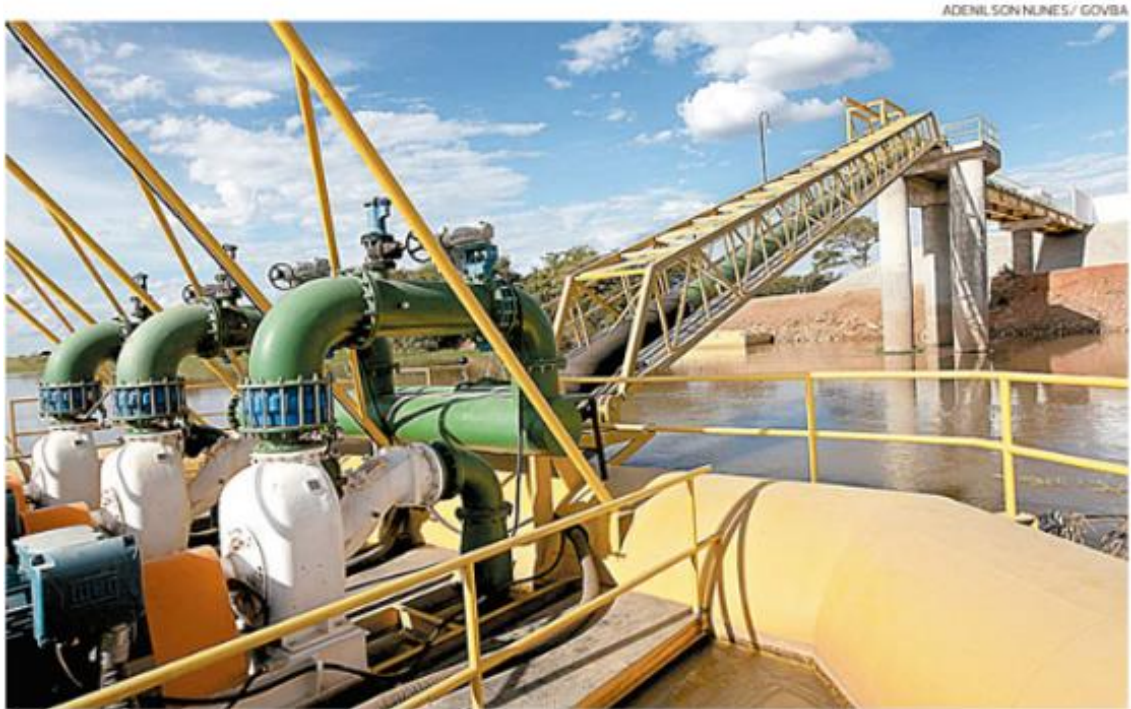
Figura 04 - Sistema de captação da adutora do rio São Francisco.
