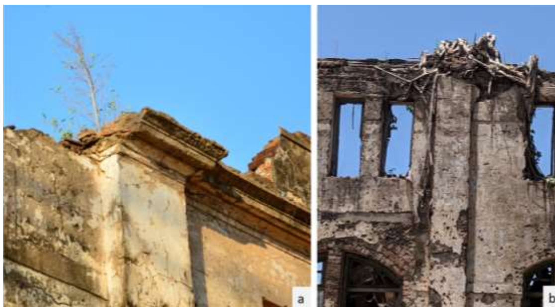
Figura 56 – À esquerda, perda de alvenaria (cimalha e platibanda) da fachada sudoeste; à direita, raiz de figueira remanescente na estrutura da parede
