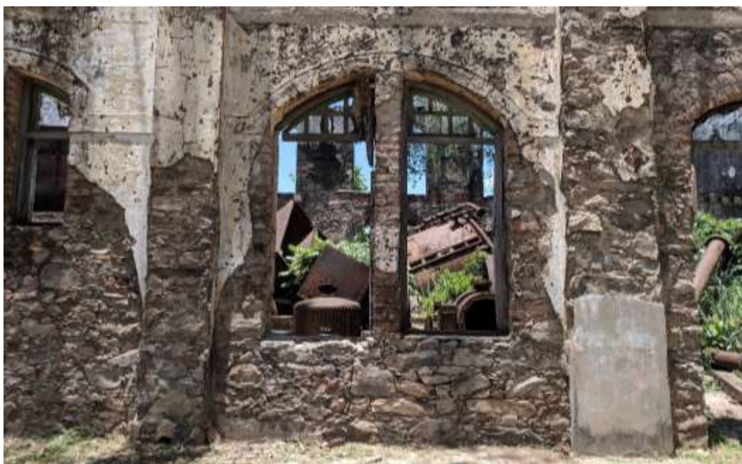
Figura 52 – Superfícies com destacamento de argamassa de revestimento
