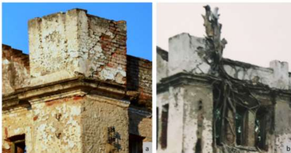
Figura 55 – Evolução de trinca existente na fachada sudoeste (SO), que se estende à fachada noroeste, ao longo dos anos: à esquerda, sua aparência atual; à direita, sua aparência prévia
