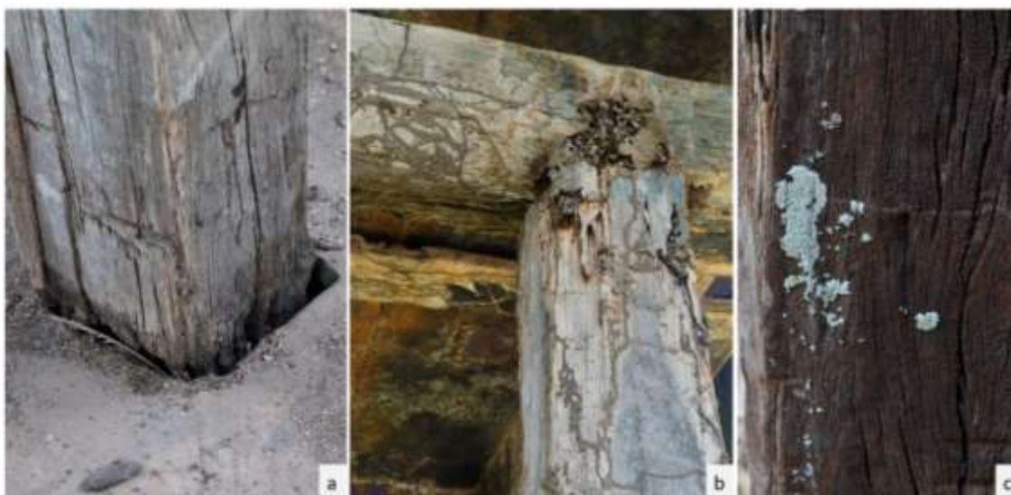
Figura 57 – À esquerda, perda de vínculo do pilar de madeira com o piso; ao centro, colmeia de abelha e galerias de cupim; à direita, presença de microrganismos na peça do pilar
