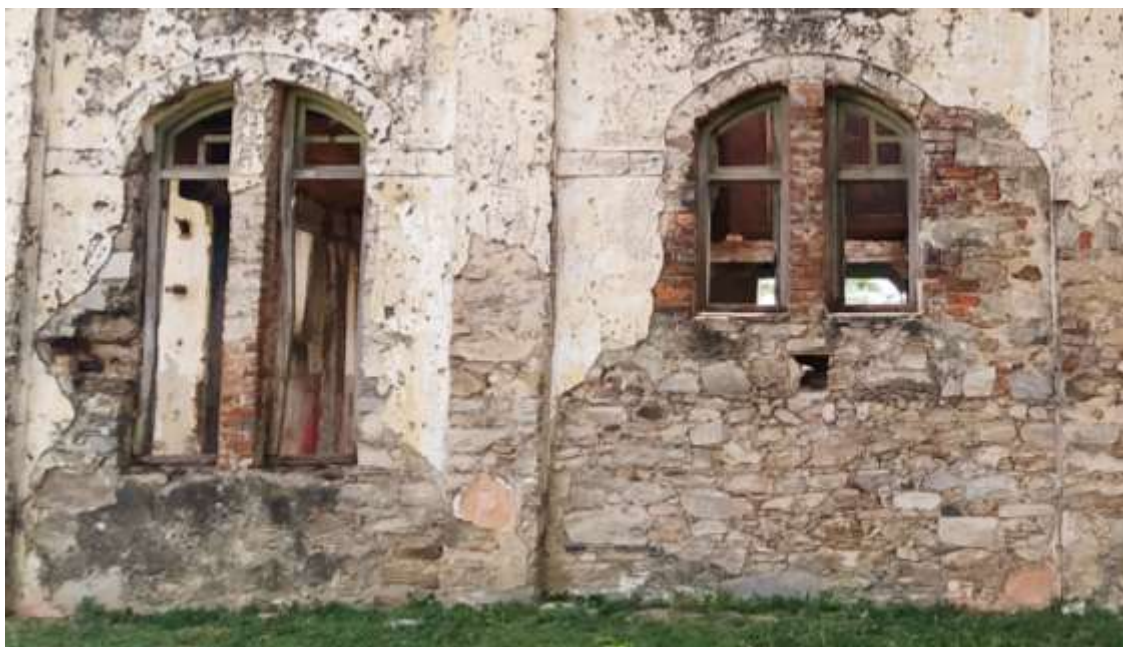
Figura 38 – Alvenaria mista de pedra e tijolos maciços
