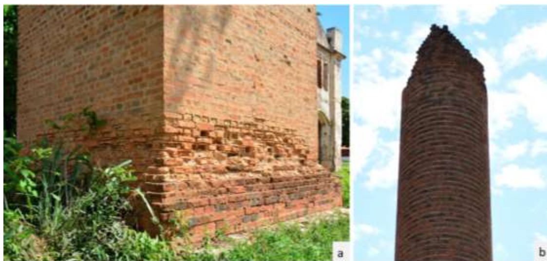
Figura 58 – À esquerda, erosão de tijolos na base; à direita, perda de alvenaria no topo do fuste
