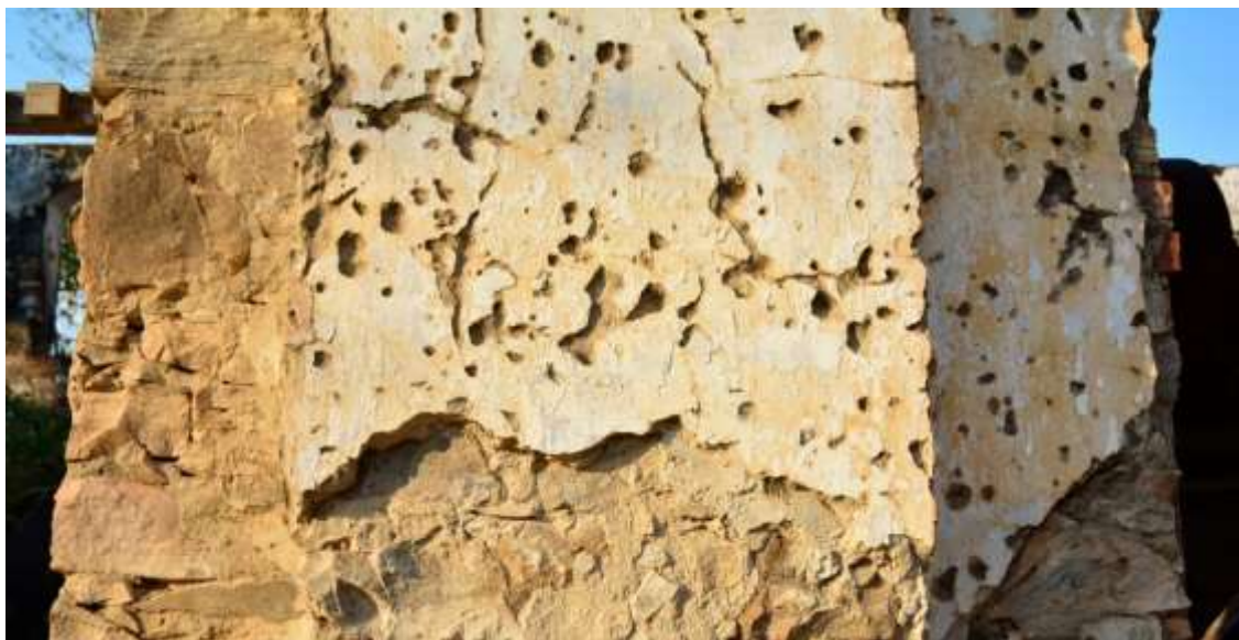
Figura 53 – Vesículas existentes em vão da fachada sudoeste
