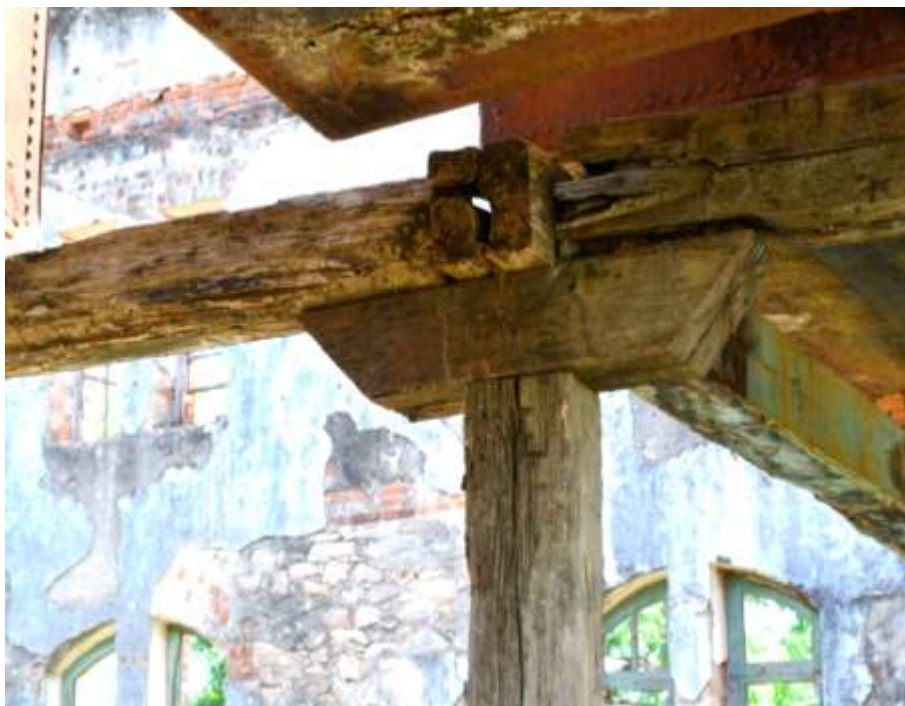
Figura 40 – Estruturas de madeira (aroeira) internas, como apoio de maquinários e passarelas
