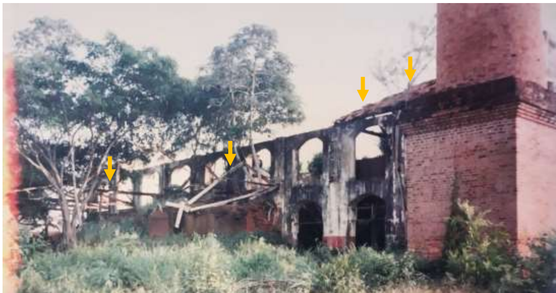
Figura 35 – Remanescentes (indicados) da cobertura lateral ao galpão principal da Usina
