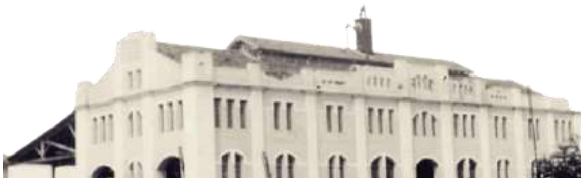
Figura 41 – Iconografia que apresenta a cobertura do edifício, juntamente ao lanternim
