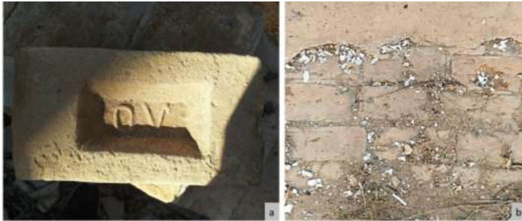
Figura 39 – Tijolo com grafia “O. V” encontrado no interior da Usina. À direita, piso em tijoleira de pedra revestido por camada cimentícia
