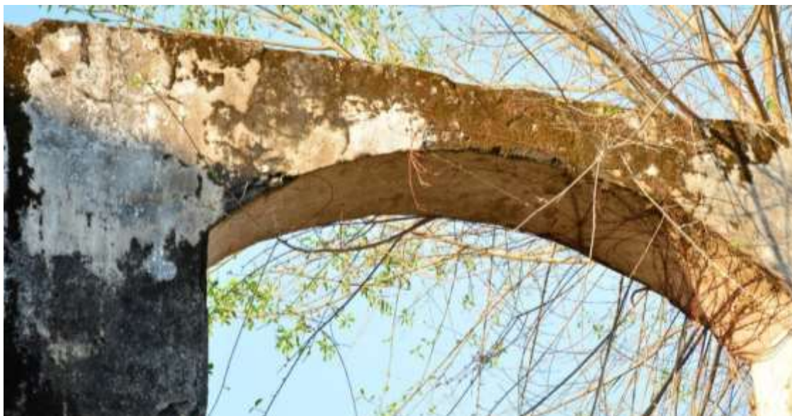
Figura 54 – Superfície de parede com a presença de biofilme
