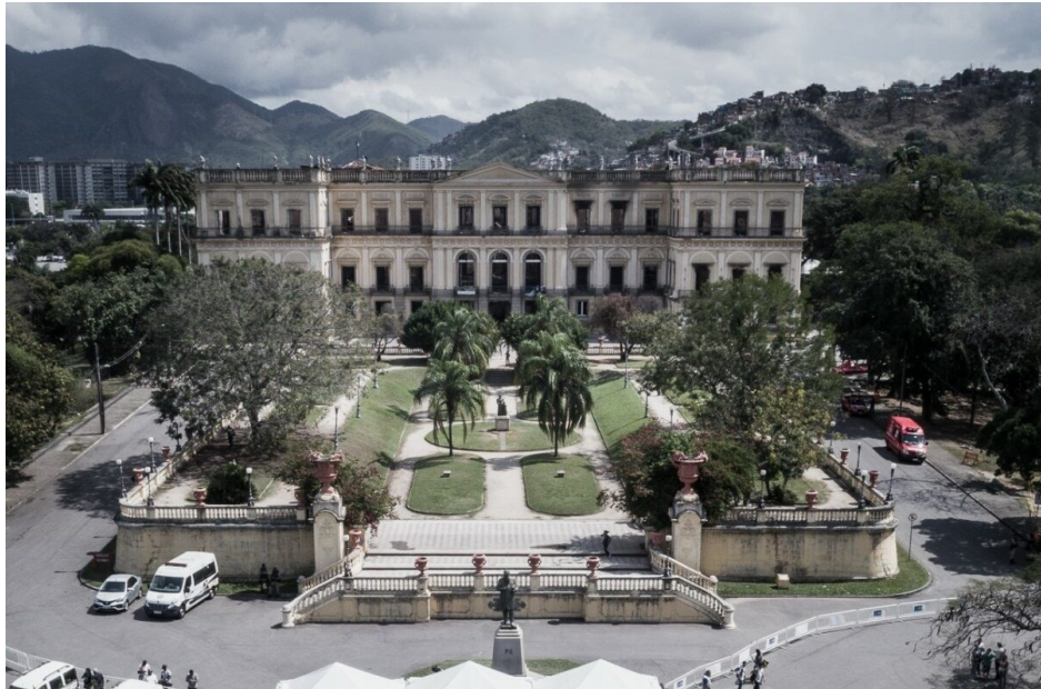
Imagem 5 - Fachada e Jardim do Museu Nacional, localizado na cidade do Rio de Janeiro 25
