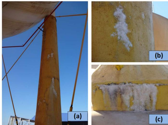
(a) Fotografia de uma perna de aço de 8 m de altura, revestida com 5 cm de argamassa cimentícia acometida por eflorescência; (b) aproximação de área de revestimento da perna e (c) aproximação da base de concreto armado, com eflorescência aparente.
