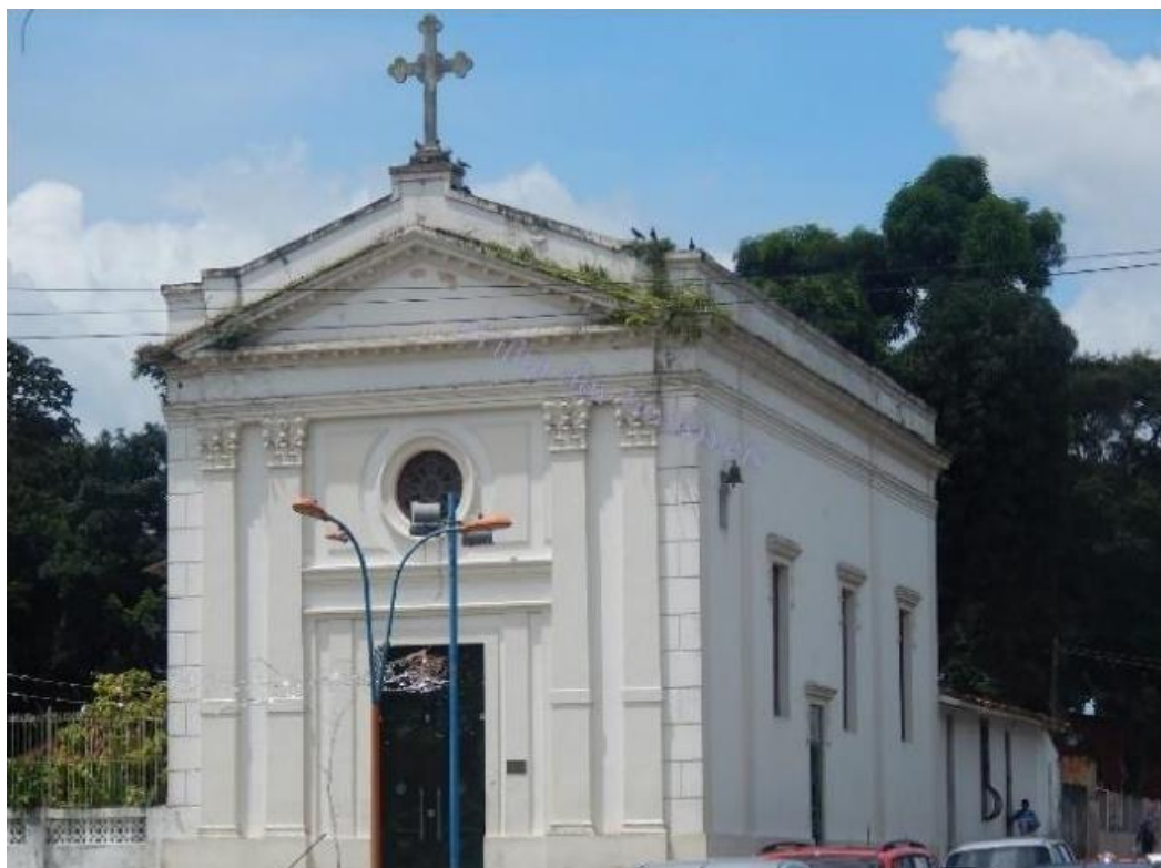
Figura 19 - Igreja de São Sebastião.
