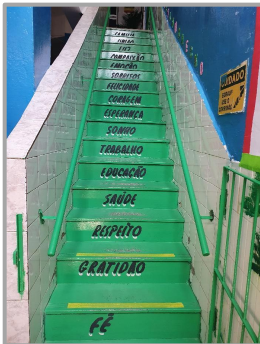
Figura 23 – Escada que dá acesso ao primeiro andar da Escola
