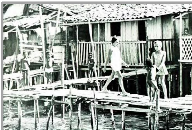
Figura 7 – Salvador, Bahia, Alagados, 1975 - pontes de acesso às palafitas
