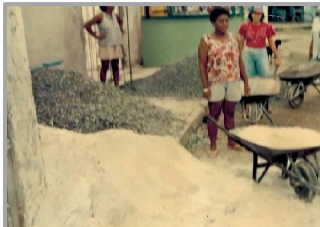
Figura 18 – As mulheres da laje trabalhando na construção do prédio que hoje abriga a escola
