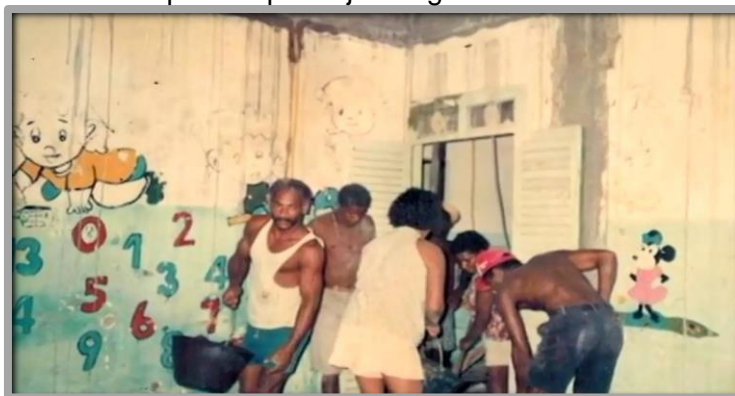
Figura 17 – Equipe trabalhando na construção do prédio que hoje abriga a escola
