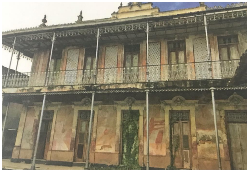
Figura 8: Foto do Casarão antes de ser reformado.
