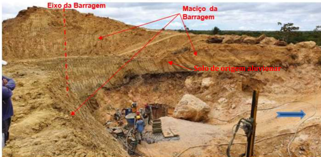
Figura 5.3 – Vista da brecha aberta para a realização dos serviços de injeções na fundação com presença de remanescente de solos transportados de coloração variegada a escura, extraído do Relatório de Reconhecimento – Inspeção de Campo.
