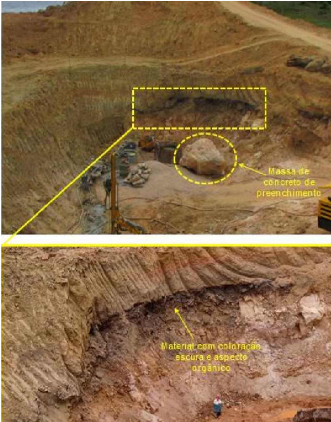
Figura 5.4 – Detalhe de remanescente de solos transportados de coloração variegada a escura no talude da brecha, extraído do Relatório de Reconhecimento – Inspeção de Campo.
