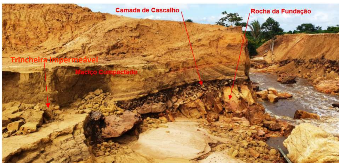
Figura 5.5 – Detalhe da estruturação do arenito na base do canal de restituição do rio Jaburu onde se realizavam os serviços de injeção na fundação sob o maciço da barragem, extraído do Primeiro Relatório de Evolução das Anomalias.
