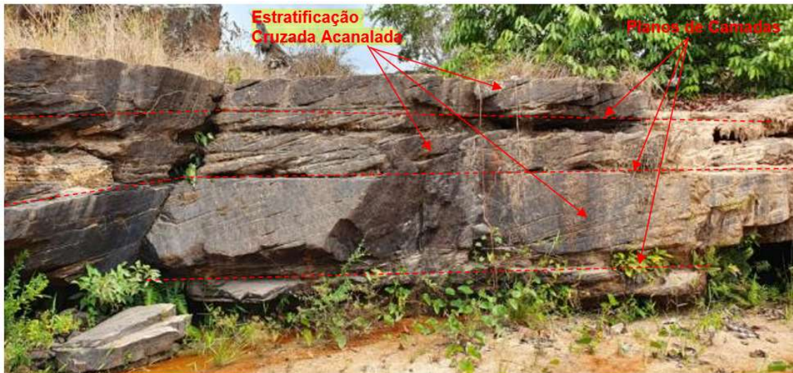
Figura 5.2 – Detalhe da estruturação do arenito na base do canal de restituição do vertedouro, extraído do Relatório de Reconhecimento – Inspeção de Campo.
