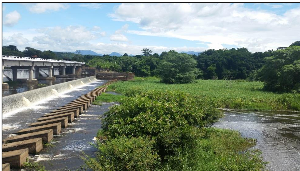
Figura 10 – Ilhas a jusante e próximas das estruturas hidráulicas da barragem
