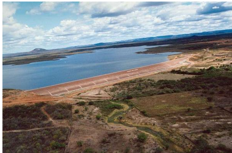
Figura 05-Barragem Terra homogênea
