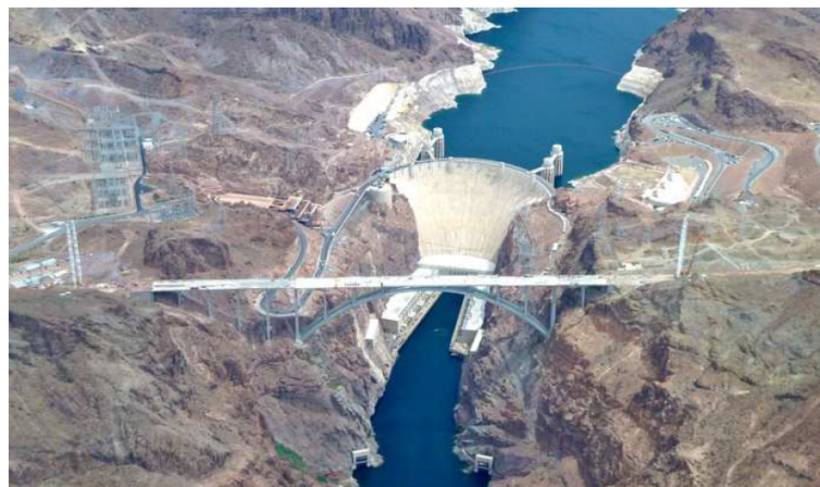
Figura 02-Barragem de Gravidade em Arco
