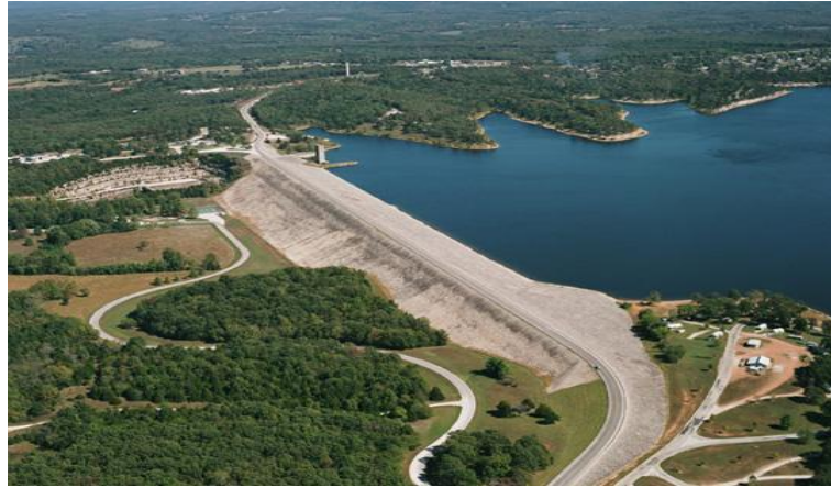
Figura 06-Barragem de Terra zonada
