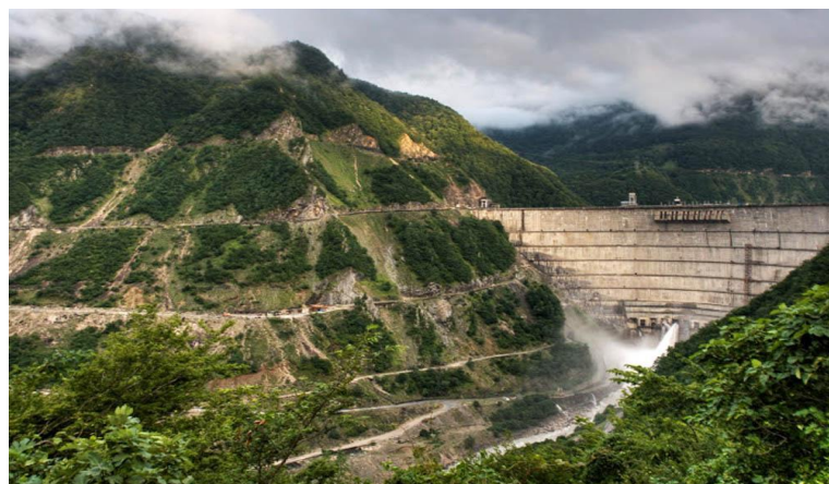
Figura 01-Barragem de Concreto em arco
