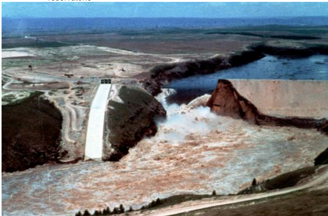
Figura 01 – Barragem Teton, EUA: piping causou rompimento durante enchimento do reservatório
