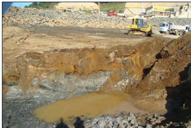
Figura 21 – Zona de fraturas no leito do rio
