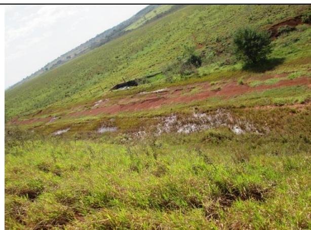
Figura 10- Vegetação diferente do corpo da barragem com a encontrada no pé
