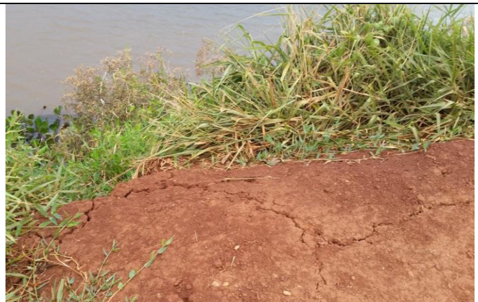
Figura 14 – Fissura
