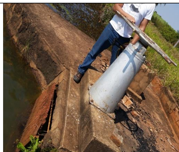
Figura 5 - Vertedor com comporta e grelha
