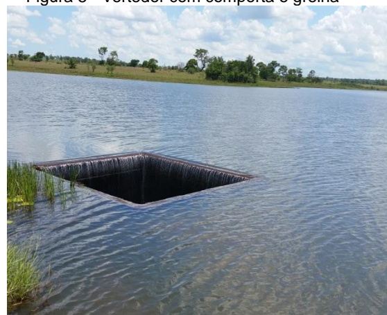
Figura 7 - Vertedor em Poço ou Monge
