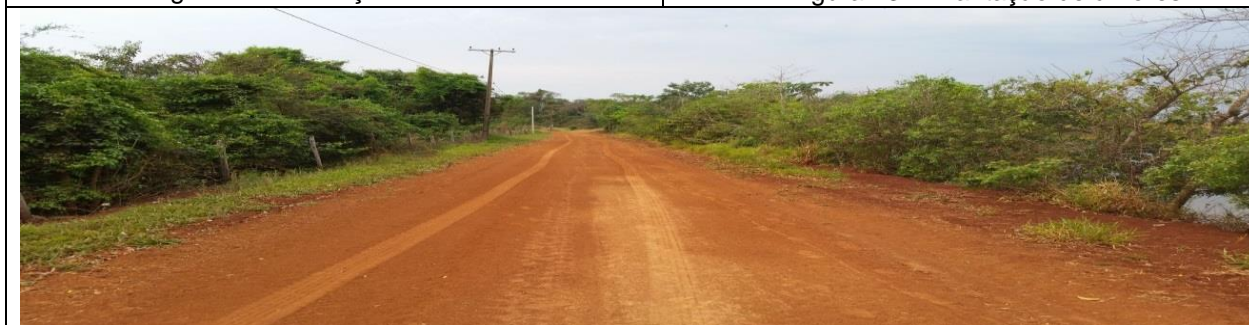
Figura 24- Vegetação densa a montante e jusante no corpo da barragem
