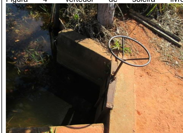
Figura 6 - Vertedor com comporta
