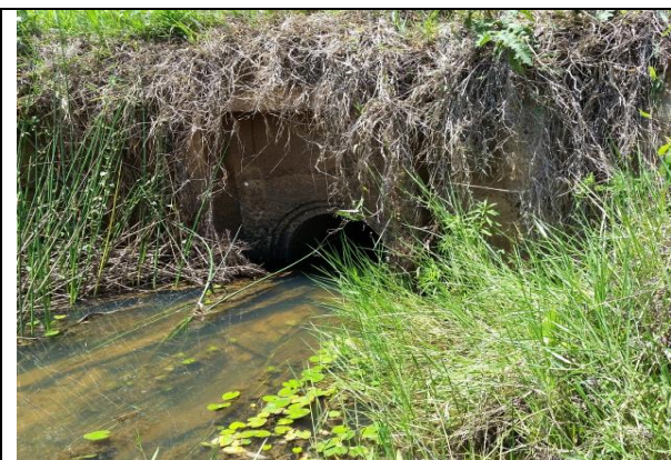
Figura 34 – Obstrução com vegetação
