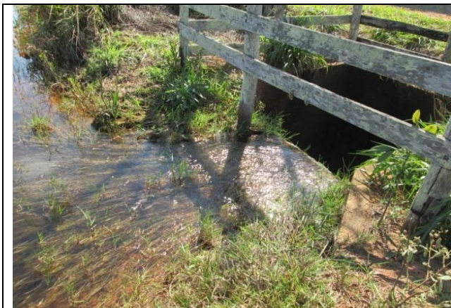
Figura 31 – Obstrução no vertedor com vegetação. Figura 32– Obstrução no vertedor com vegetação
