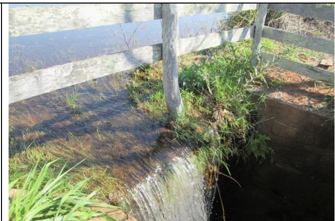
Figura 31 – Obstrução no vertedor com vegetação. Figura 32– Obstrução no vertedor com vegetação
