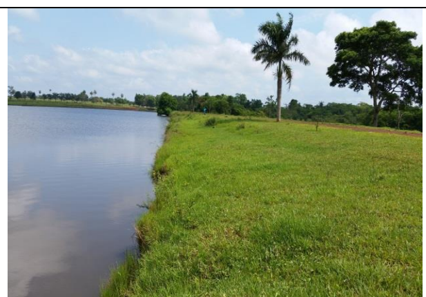
Figura 19-Talude com boa cobertura vegetal
