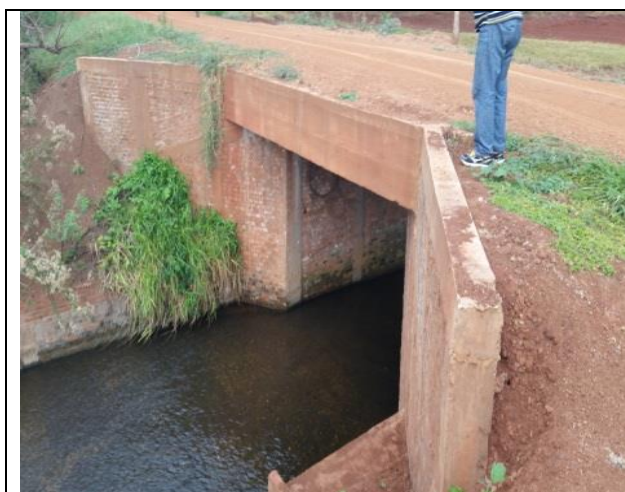
Figura 4- Vertedor de soleira livre
