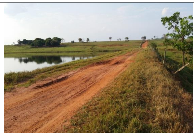
Figura 39- Abatimentos da barragem
