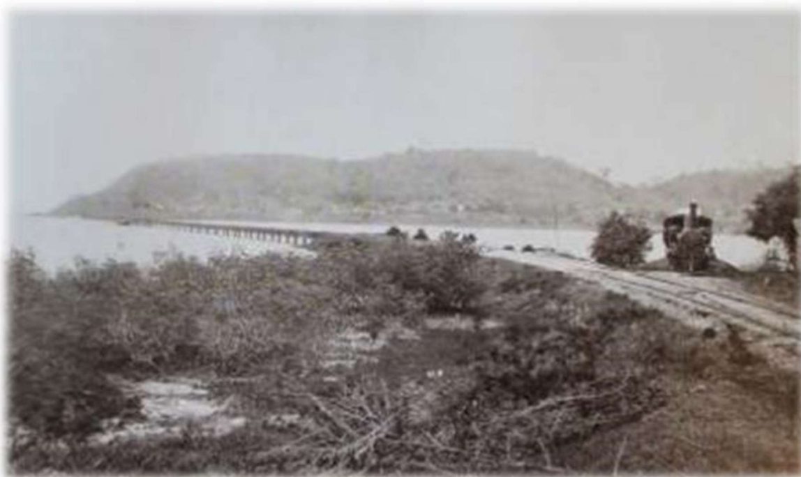
Figura 3 – Viaduto de Itapagipe da Bahia and San Francisco Railway
