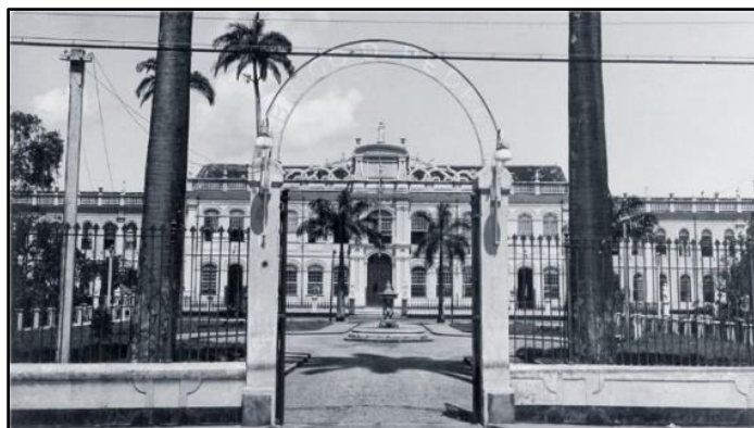
Figura 2: Asilo da Mendicidade
