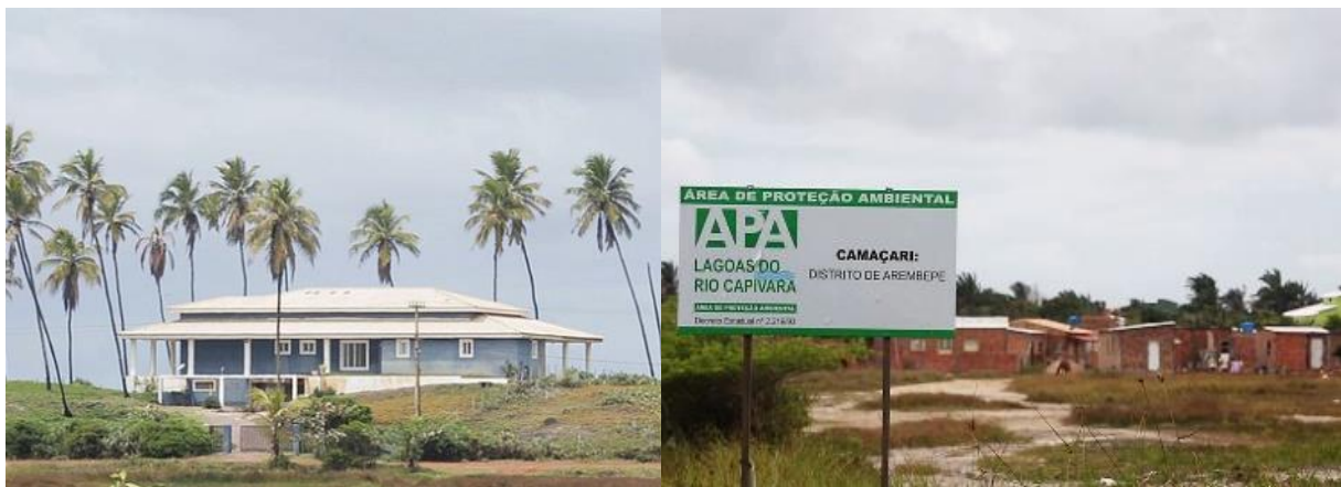
Figuras 23 y 24. Viviendas ubicadas en urbanización ilegal Sangradouro, Arembepe, dentro de APA Capivara.
